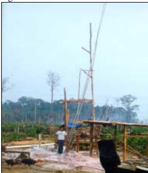
Foto 25 – Poço sendo construído artesanalmente em comunidade rural
