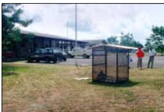
Foto 39 – Reservatório para o lixo hospitalar localizado indevidamente na entrada do Hospital de Balbina
