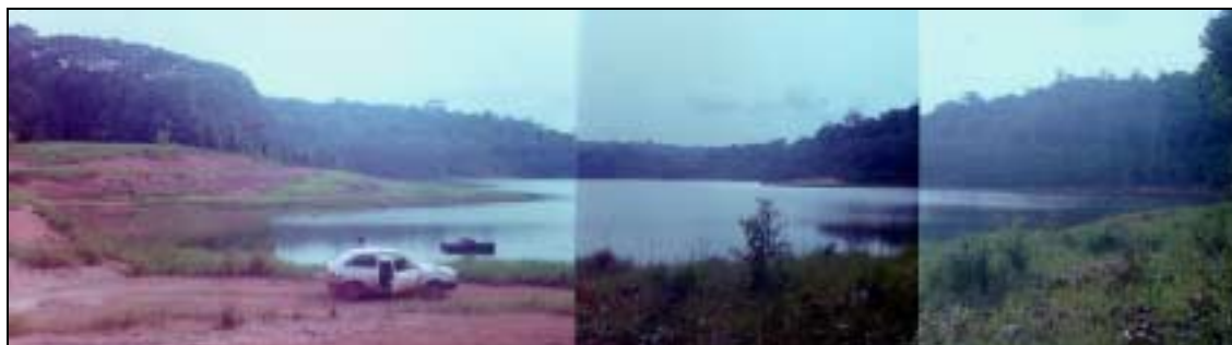
Foto 24 – Área de captação d'água da Vila Pitinga a partir do lago artificial formado pelo represamento do igarapé Sete de Setembro
