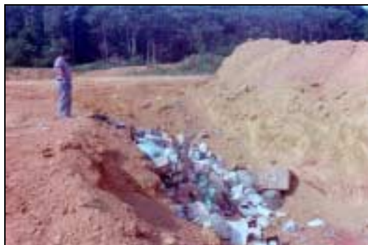
Foto 41 – Detalhe da trincheira com lixo no Aterro Sanitário da Vila Pitinga
