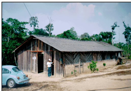
Foto 15 - Galpão improvisado onde funciona a escola da Comunidade São Francisco
