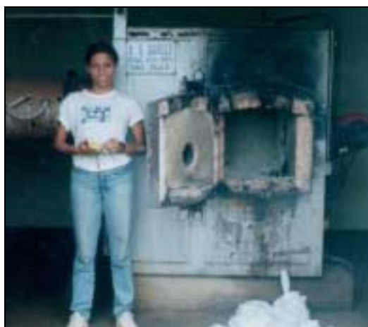
Foto 42 – Incinerador do Hospital da Vila Pitinga
