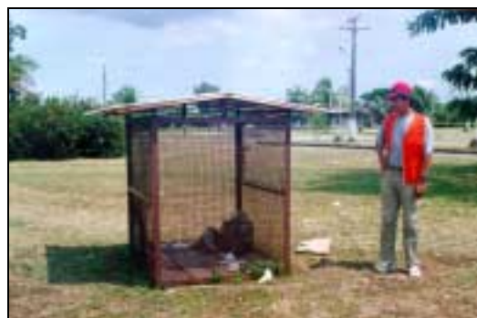
Foto 40 – Detalhe do reservatório de características impróprias para acúmulo de lixo hospitalar
