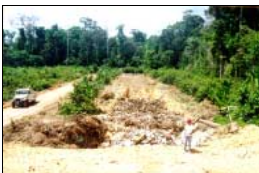
Foto 32 - Aspecto da trincheira preenchida por lixo. Aterro Sanitário de Presidente Figueiredo
