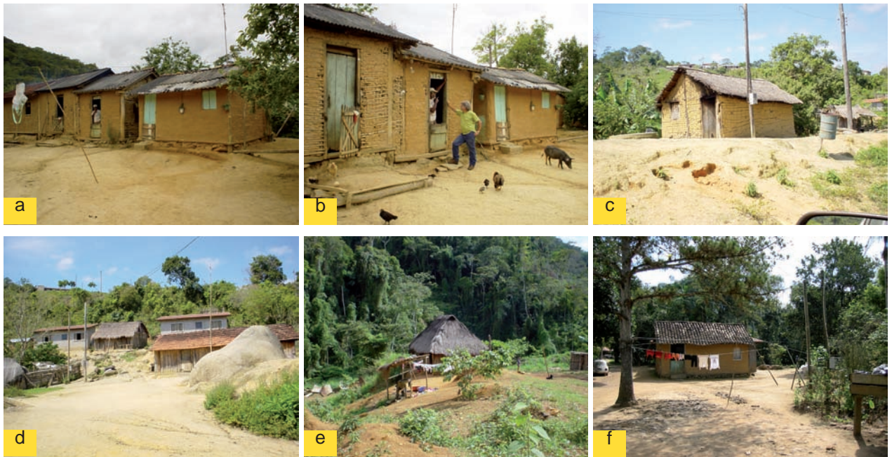
Figura 74 - Cenas da arquitetura em taipa, comum nas comunidades quilombólas e fora delas. Tipo construtivo que, aos poucos, vem sendo substituído por casas em alvenaria, financiadas pelo governo — opção questionável, pela descaracterização de costumes históricos (Figura f). Talvez melhor fosse optar por pela melhoria construtiva da prática da taipa do que extingui-la. Figuras a e b: quilombo; figuras c e d: Quilombo Calcumê
