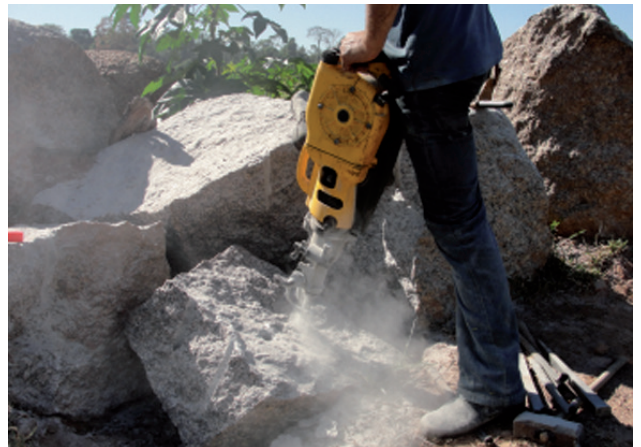
Foto 6.45 – Granitóide porfiróide – Detalhe da retirada dos blocos
