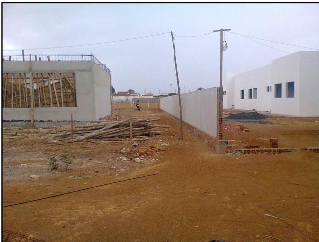
Fotografia 10 – Situação das construções da creche e do colégio na Área 1 em julho de 2013.
