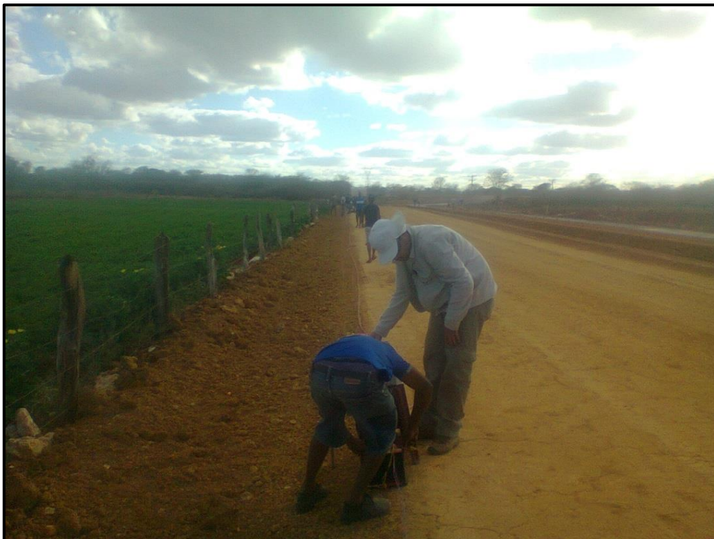
Fotografia 14 – Levantamento de eletrorresistividade na nova Av. Perimetral.
