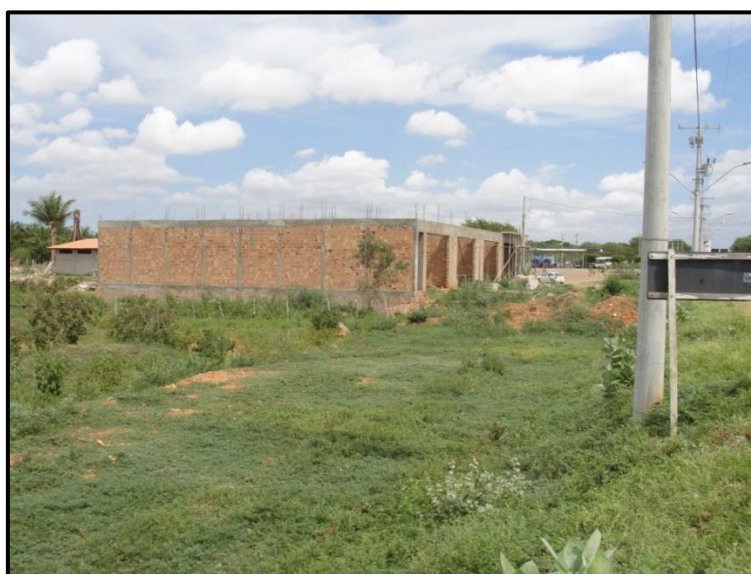
Fotografia 9 – Área colapsada na margem da BA-432 próximo da entrada de Lapão.
