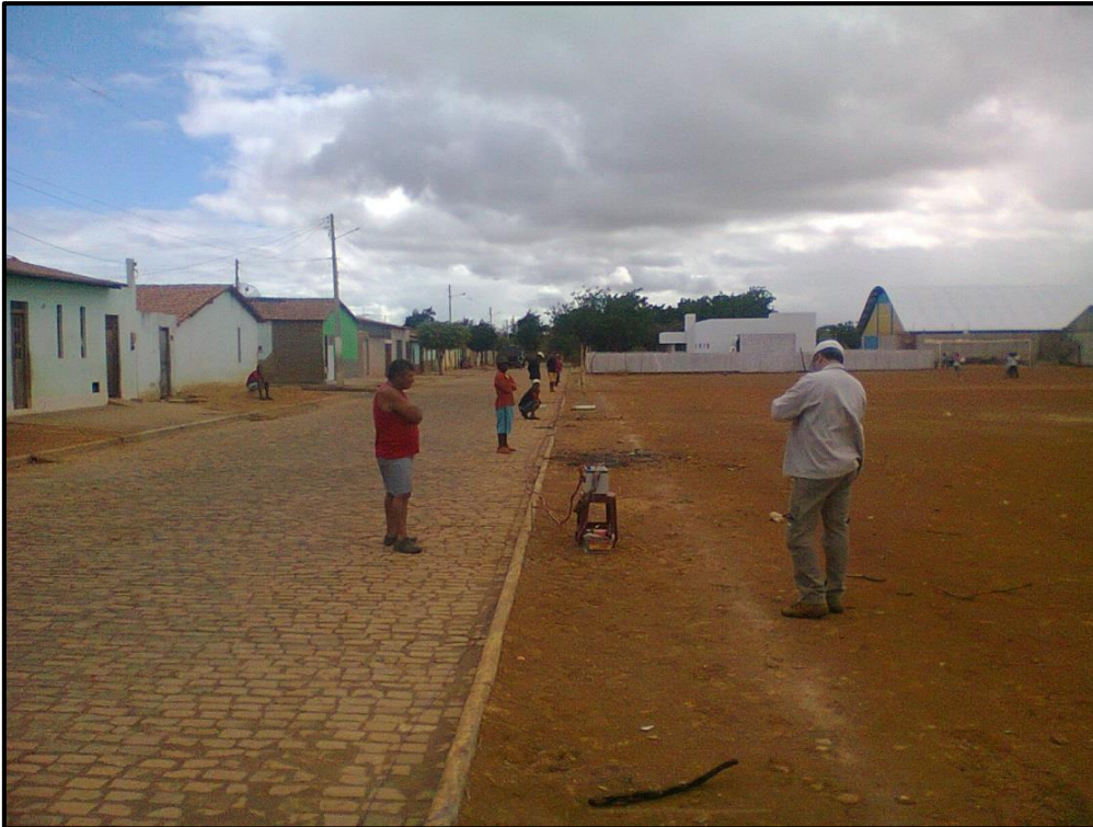
Fotografia 11 – Visão ao fundo do ginásio de esportes que está sendo construído na Área 1. Situação em julho de 2013.
