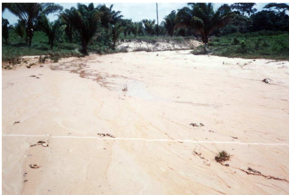
Foto 9. Assoreamento em drenagem. Rodovia BR-364, próximo à Vila Guaporé.
