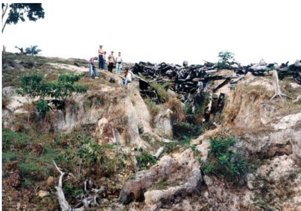
Foto 23. Proteção de voçoroca para deter expansão.
