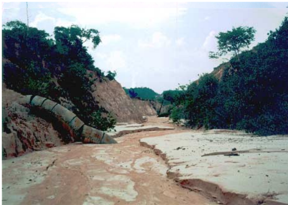
Foto 11. Voçoroca em sedimentos coluvionares. Proximidades da Rodovia BR-364. Vila Guaporé.
