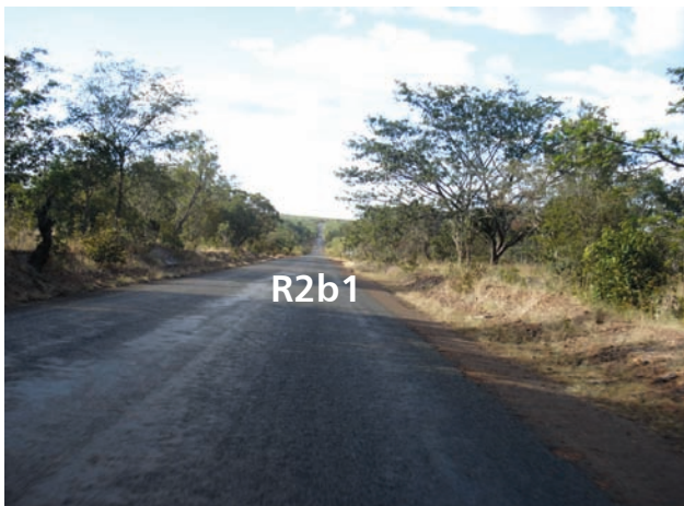
R2b1 – Baixos platôs não dissecados da bacia do Parnaíba (estrada Floriano-Picos, próximo a Oeiras, Piauí).
