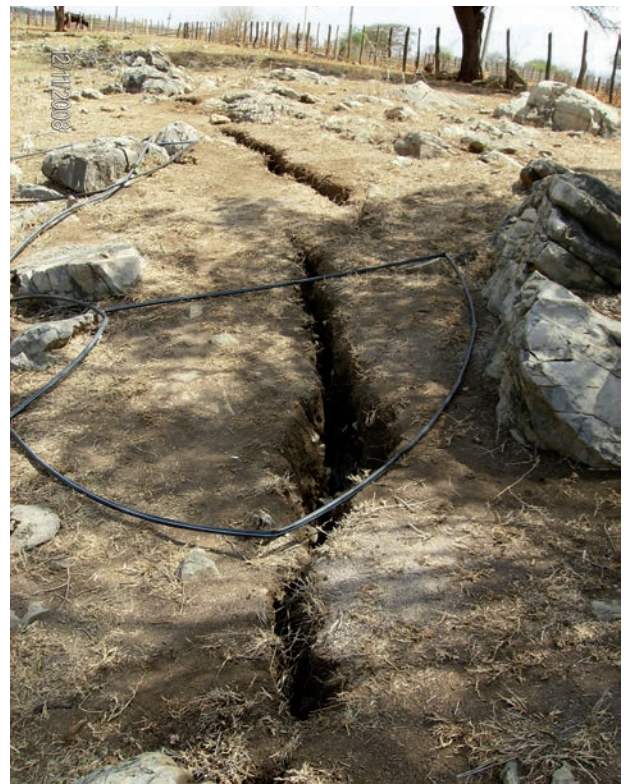
Figura 5.54 – Fendas no solo na periferia da cidade de Lapão
