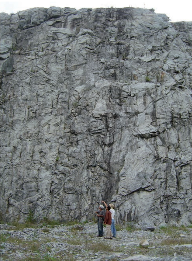
Figura 5.82 – Frente de lavra paralisada em ortognaisses granulíticos bastante fraturados (Jacobina, BA).
