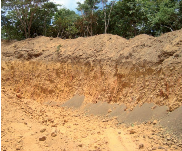
Figura 5.21 – Cobertura detrito-laterítica usada para pavimentação de estradas (Ipirá, BA).
