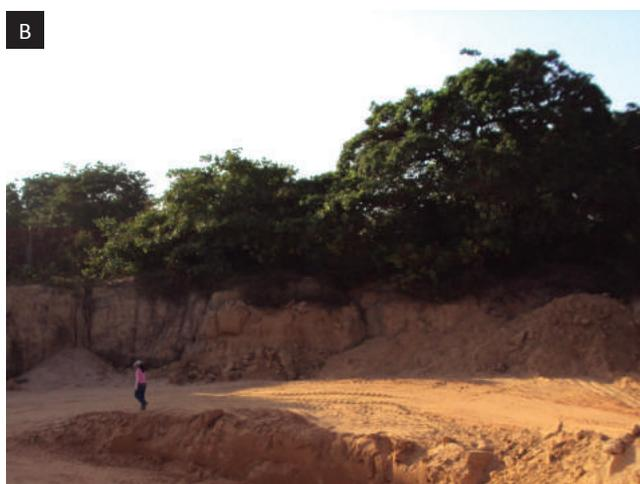
Foto 5.2 – Lavra de argila mostrando vegetação afetada pela perda de resistência do solo (a); instabilidade de talude, causada por erosão (b).
