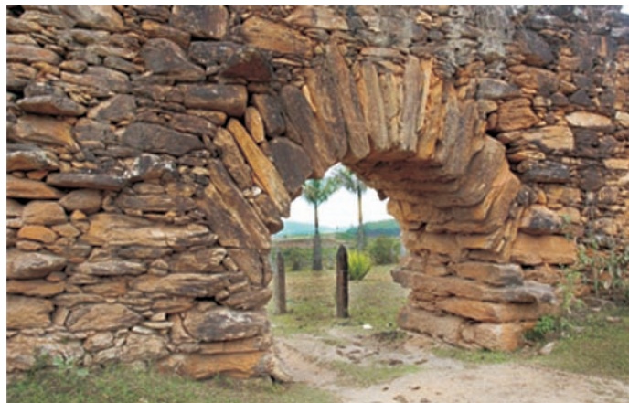
Figura 7 - Aqueduto Bicame de Pedra exibindo portal em arco romano. Foto: Virginio Mantesso Neto.
