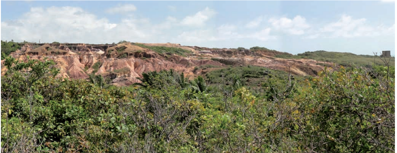
Figura 29 - Visão geral do Geossítio Vila de Nazaré mostrando a rocha granítica fortemente intemperizada. Na extremidade direita avista-se a Casa do Faroleiro.
