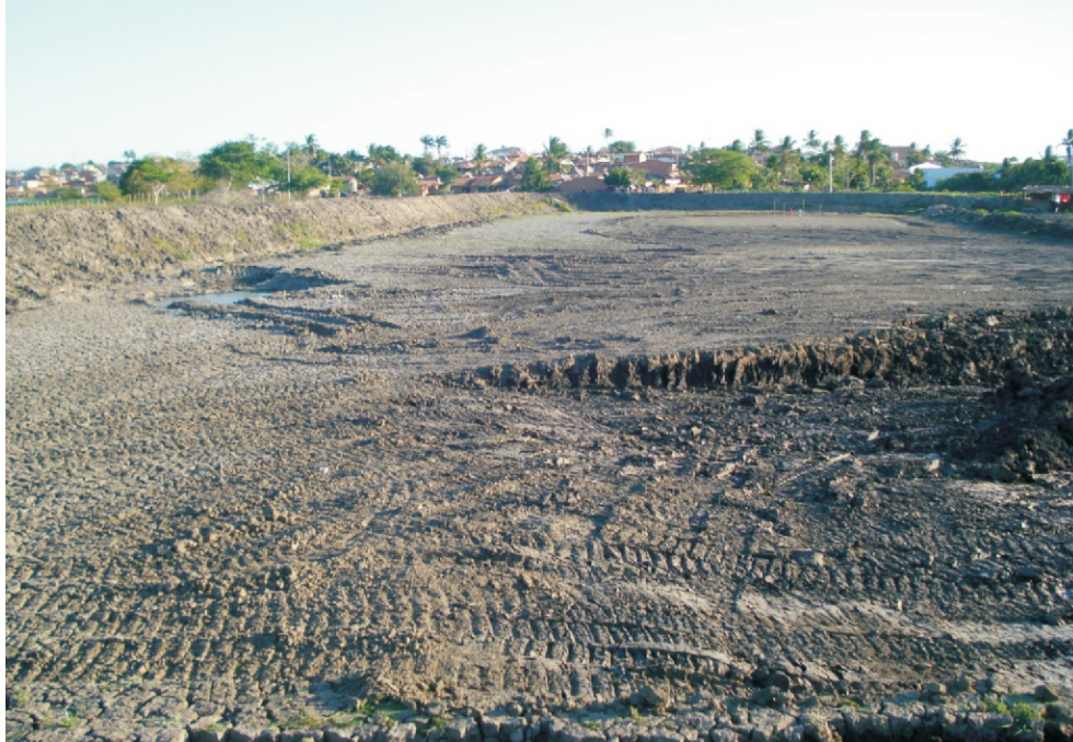
Foto 7.18 - Escavação de um depósito de várzea para ampliação de um tanque, para criação de peixe. Argila usada em cerâmicas. Área conhecida como Lagoinhas, na periferia da cidade de Cedro de São João (amostra 42Arg).
