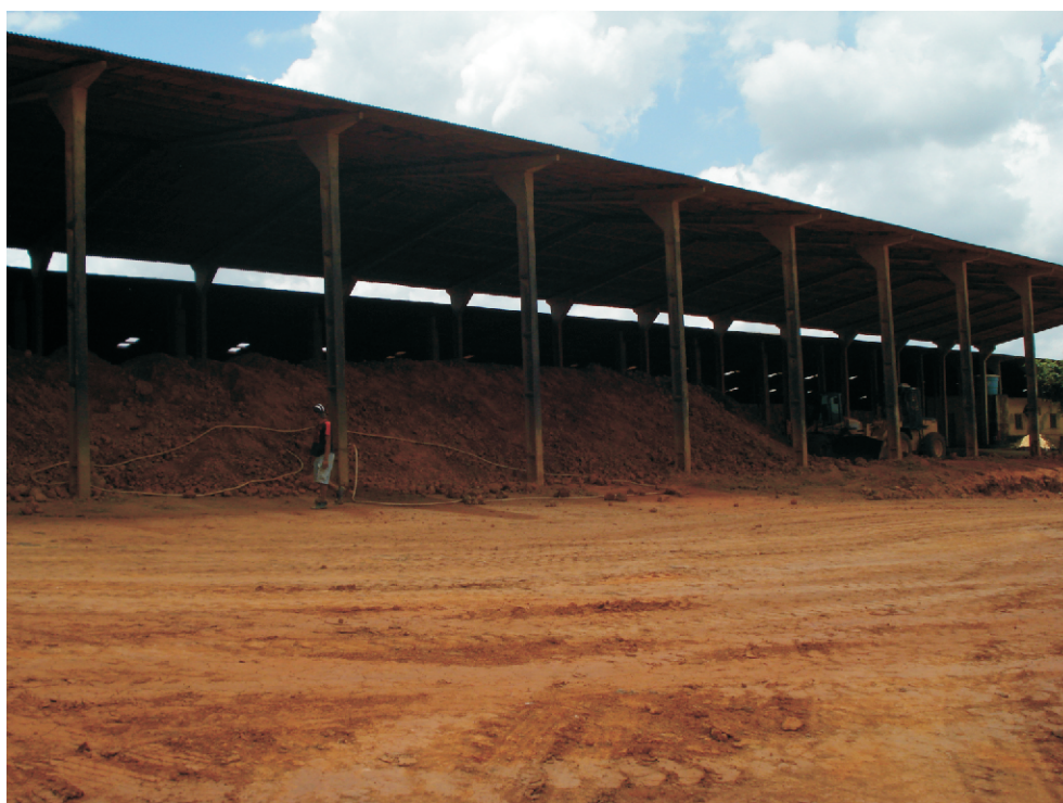
Foto 7.10 - Galpão para homogeneização de argila da Cerâmica São José, município de Itabaianinha.
