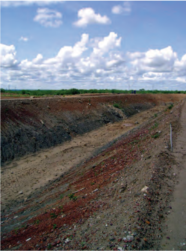
Foto 1.1 – Abertura do canal que compõe o Eixo norte do “Projeto de integração do Rio São Francisco com as bacias hidrográficas do nordeste setentrional”.
