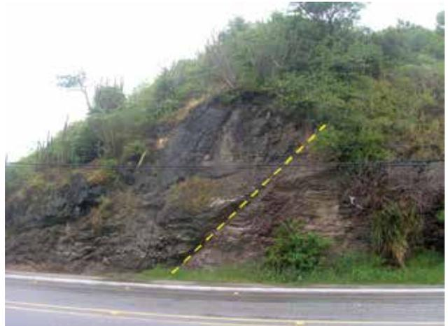
Figura 9.17 - Falha do Dormitório das Garças: movimento de deslizamento entre dois blocos de rocha
