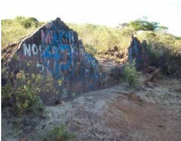
Foto 3.16 – VH-212. Falha de gravidade no contato entre as formações Inajá e Tacaratu. Pernambuco.
