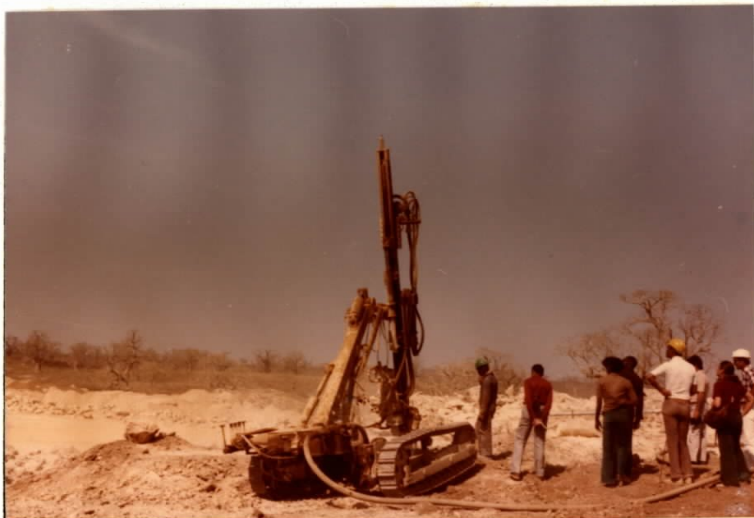
19 - Lam-Lam - Furação para detonação.
