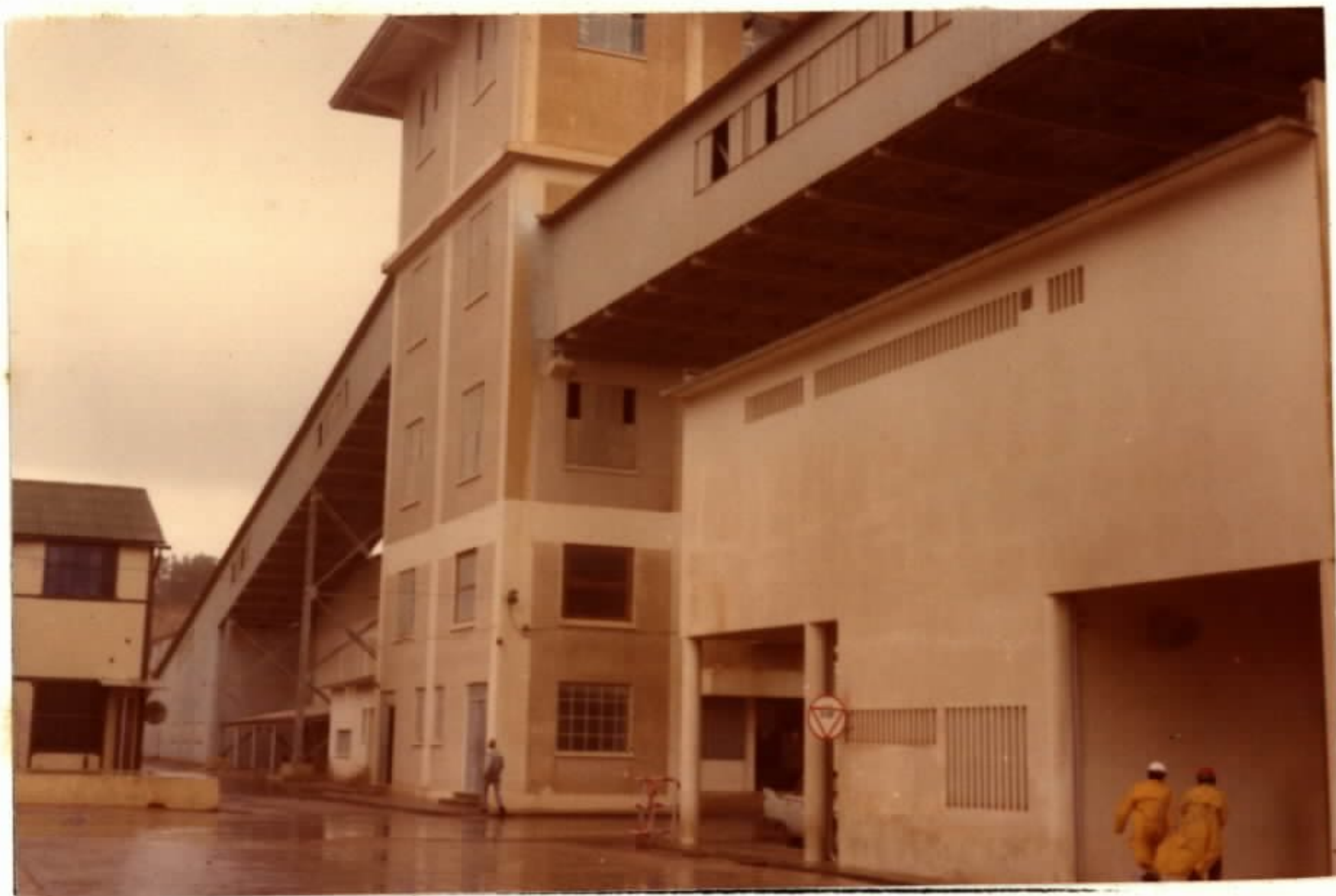
13 - Porto de Safi - Sistema de correias transportadoras.
