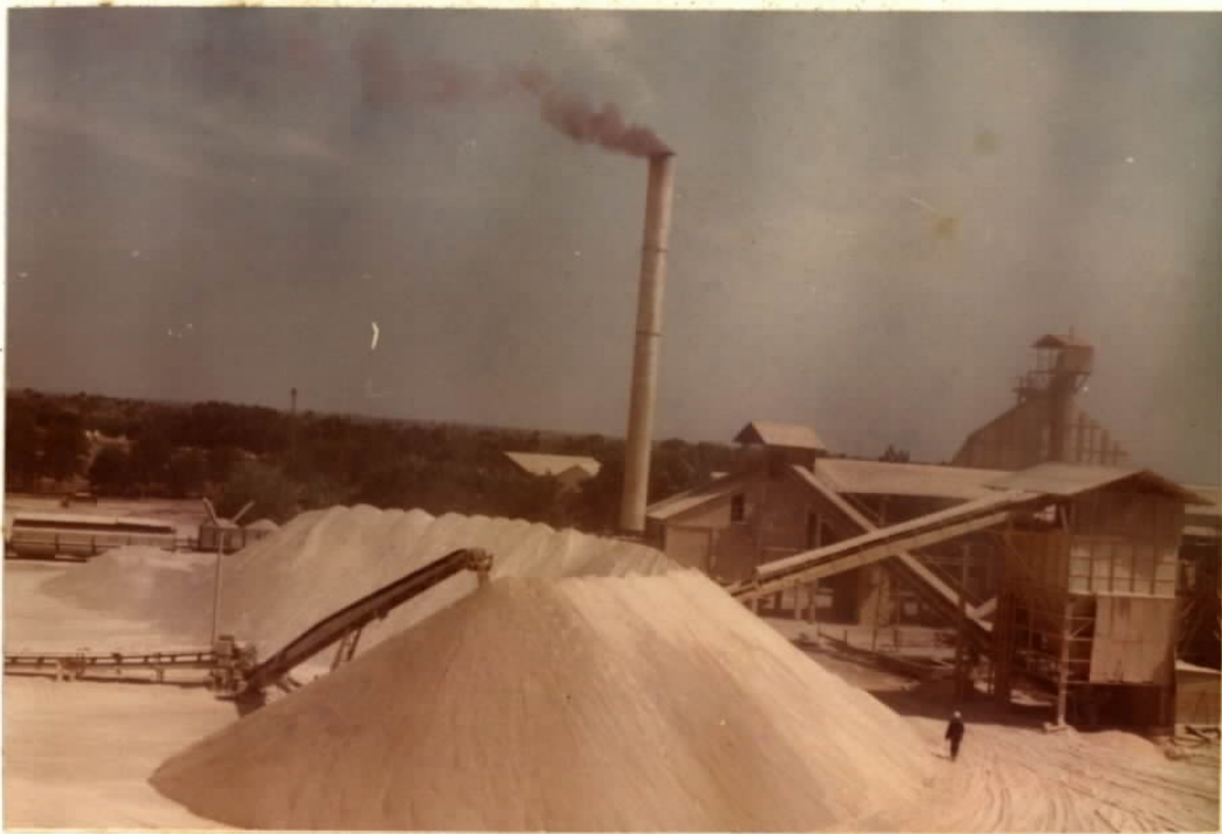
20 - Lam-Lam - Instalações de beneficiamento vendo-se em primeiro plano o estoque de minério calibrado acima - de 2mm.
