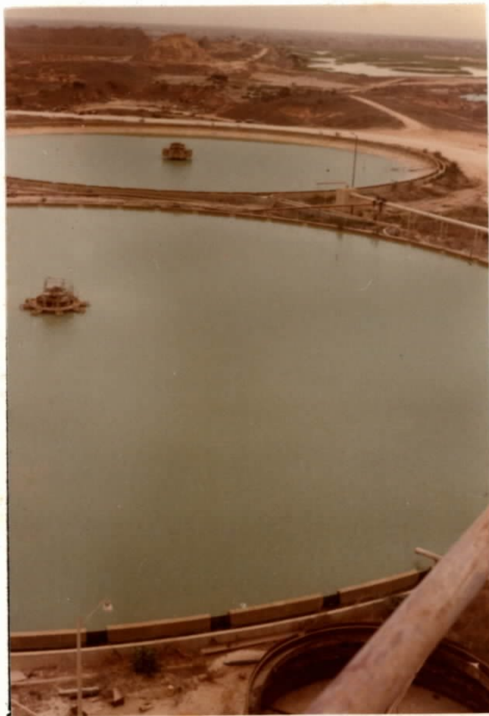
29 - Taiba - Instalações de beneficiamento: espessadores , vendo-se ao fundo as barragens de decantação.
