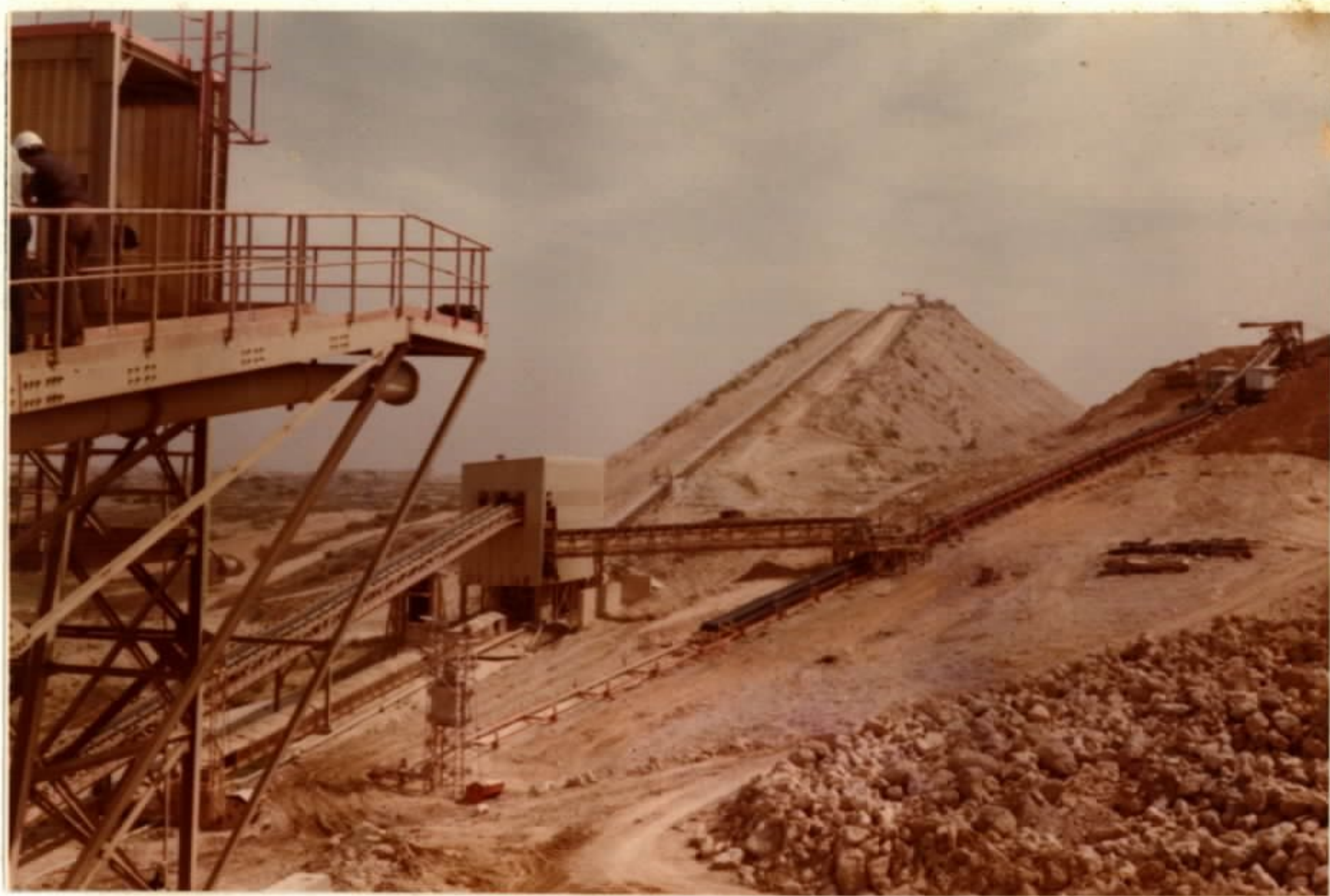
9 - Youssoufia - Instalações de Beneficiamento.
