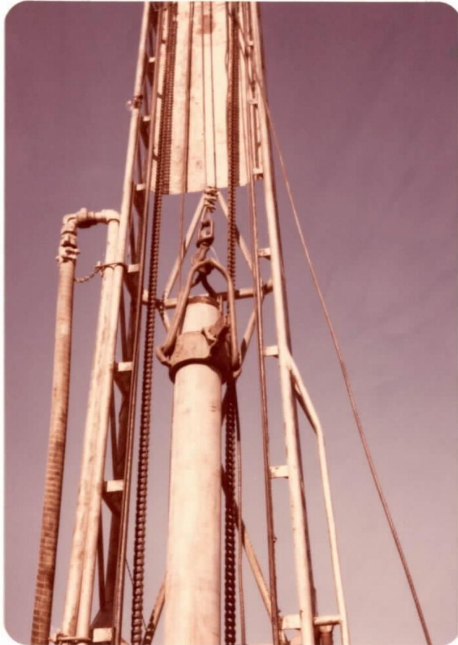
FOTO 5 - Chaves para içamento de revestimento (Sonda MAY HEW 1000).
