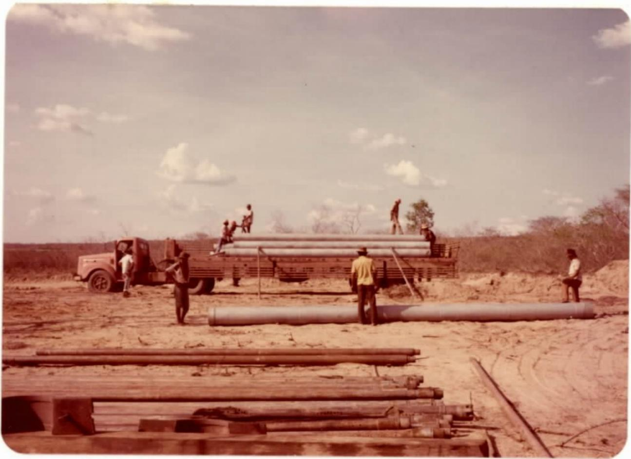
FOTO 30 - Carreta carregada com tubos de revestimento galvanizado.
