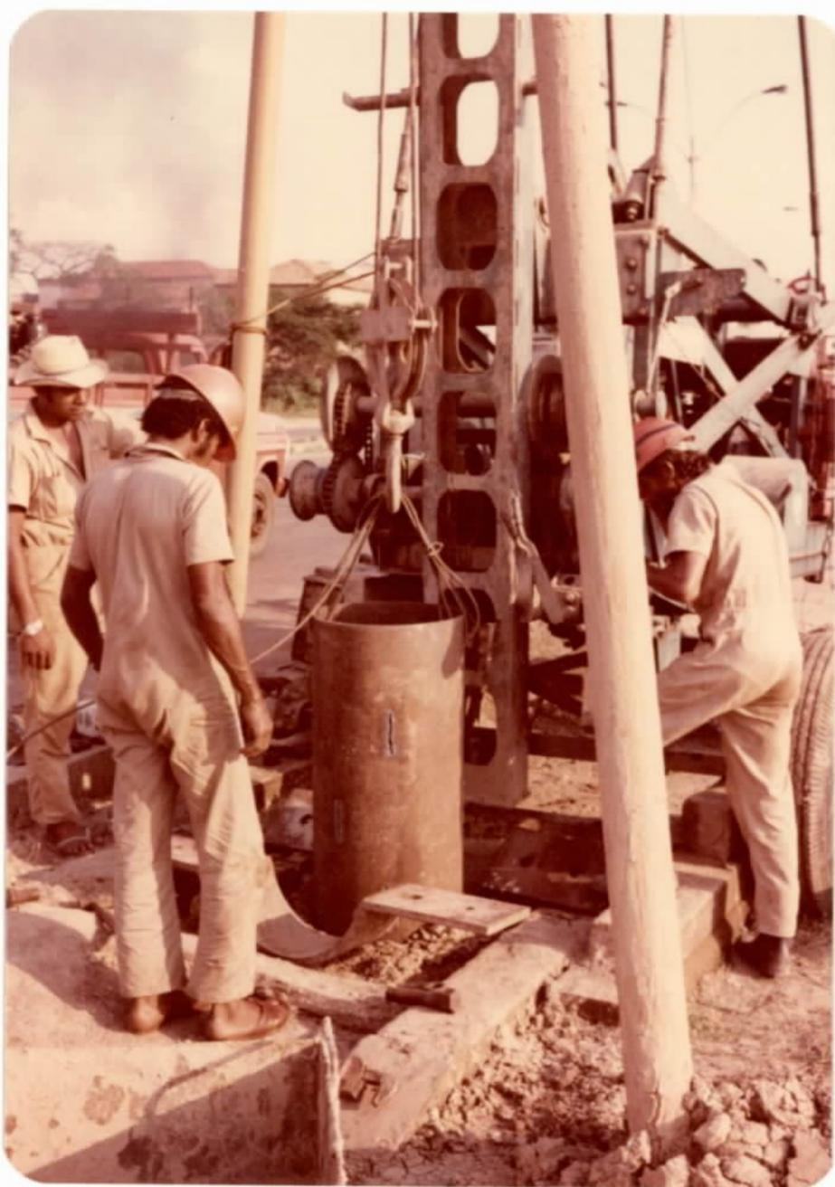
FOTO 20 - Descida de revestimento ranhurado de 20" com uma sonda a percussão SS-71.
