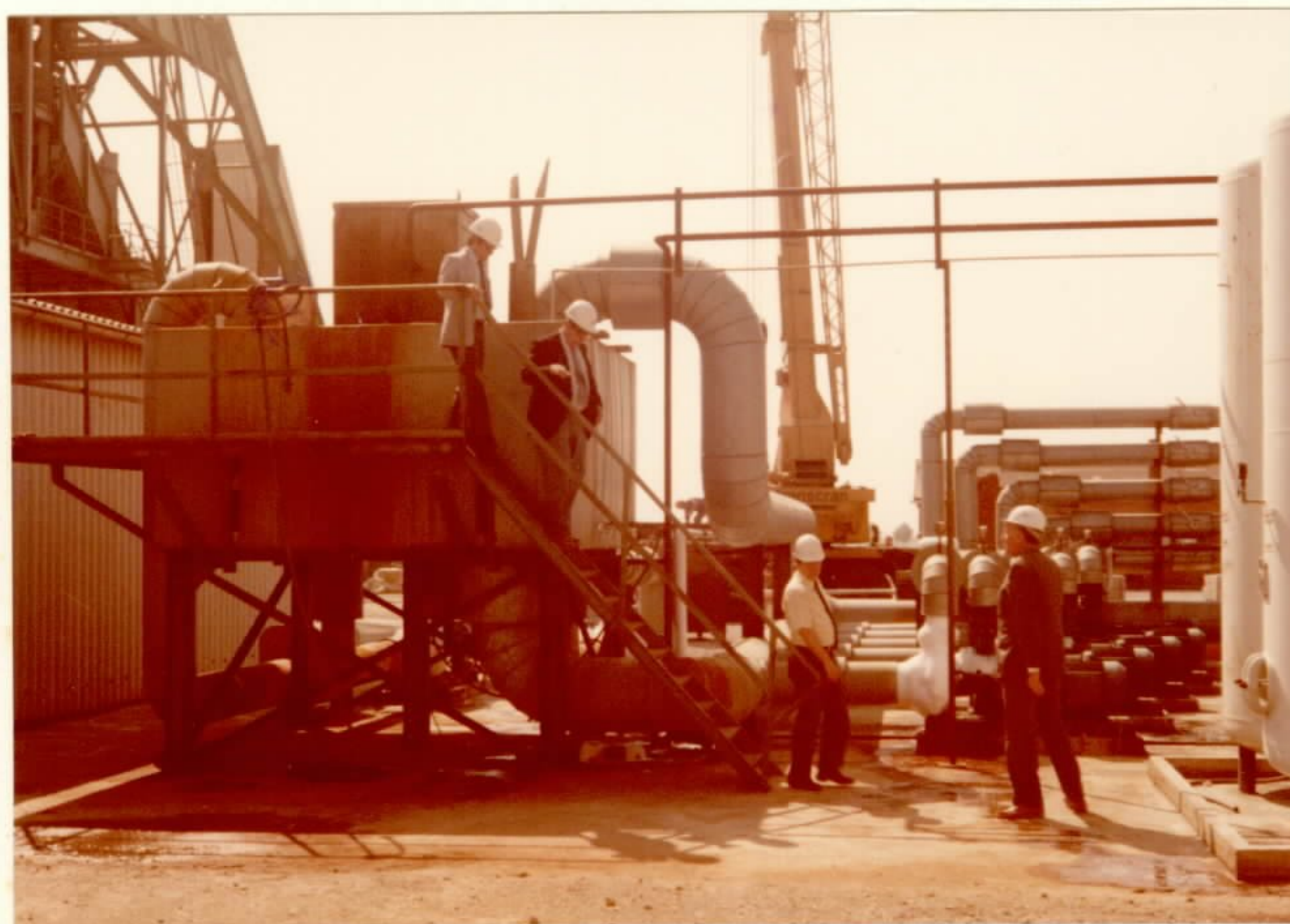
Foto 10 - Instalações de bombeamento do fluido congelante
