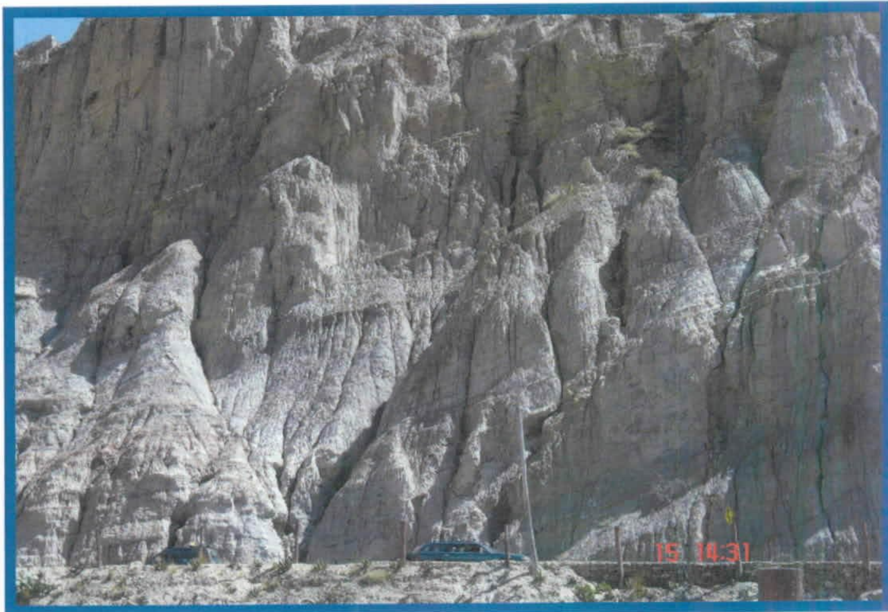
Figura 24- Encostas íngremes constituídas por rochas sedimentares (arenitos e siltitos) fortemente erodidas.
