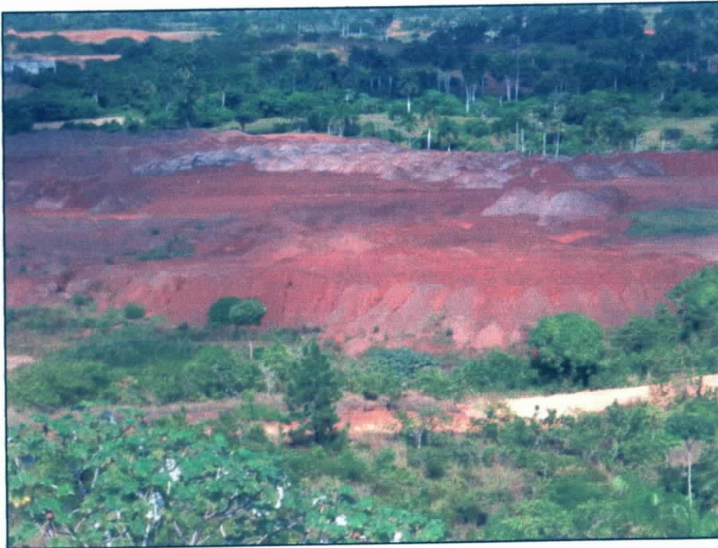
Figura 12 - Vista parcial de uma colera existente na Mina de Castellano. Nota-se que não há a proteção com manta PEAD.
