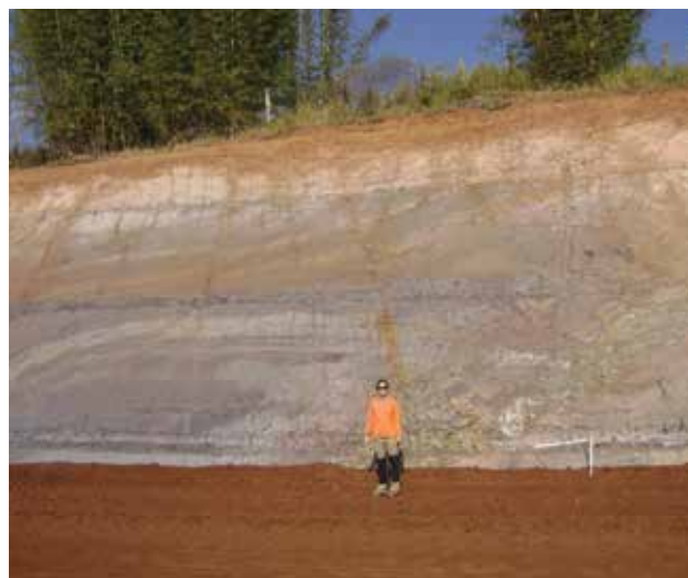
Figura 5.28 – Filito cinzento de aspecto rítmico em corte da rodovia BR 262, oeste da cidade de Juatuba
