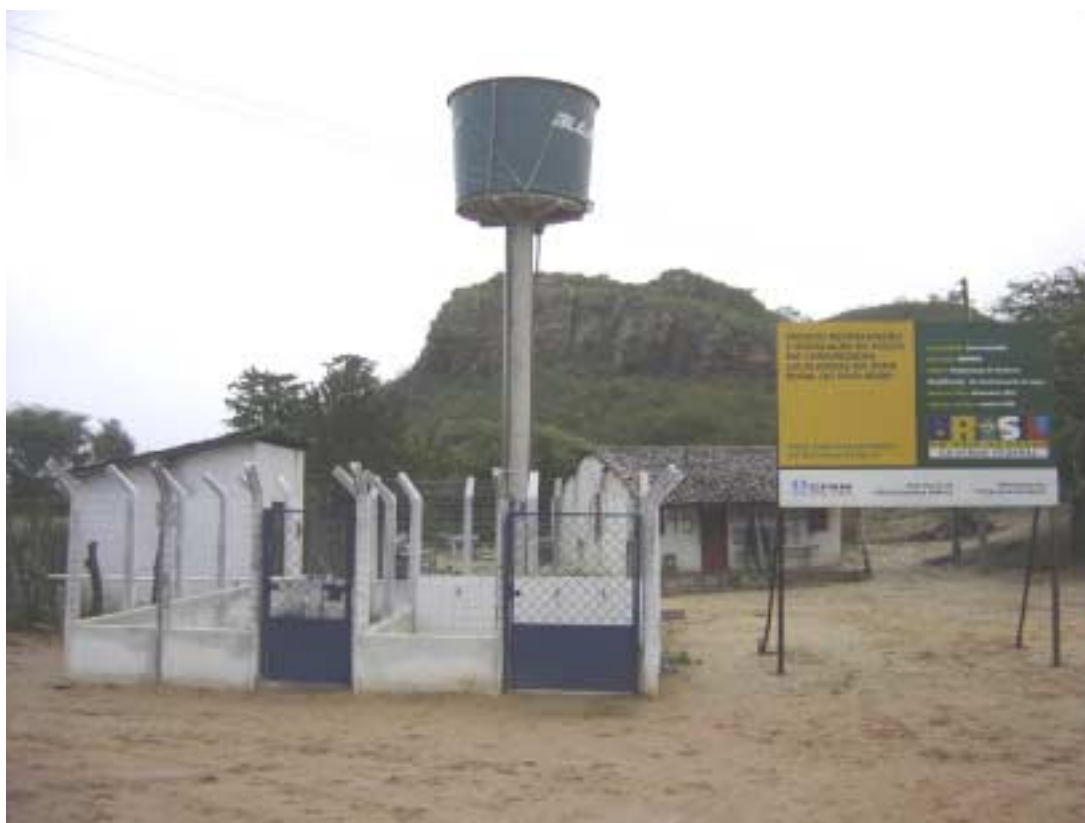
Foto 8.1 Aspectos do SSA Serra Vermelha concluído
