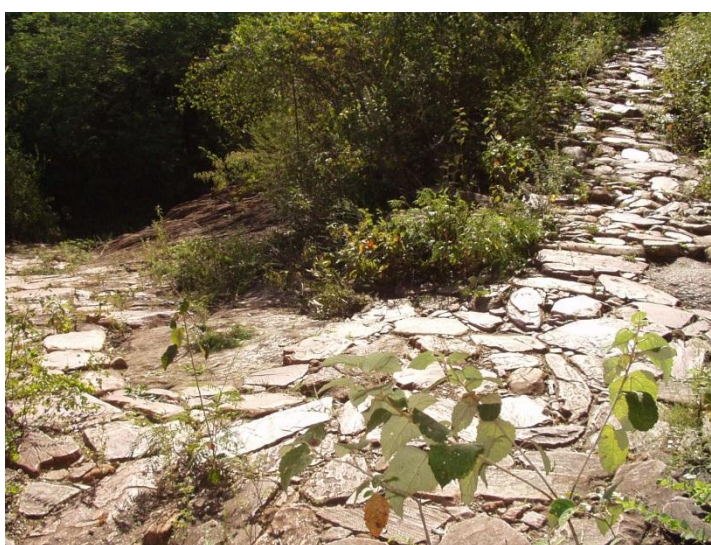
Figura 102. Trecho pavimento em declive da Estrada Real, Rio de Contas. Foto: Carlos Costa, 2007. Figure 102. Sloped, paved excerpt of the Estrada Real, Rio de Contas. Photo: Carlos Costa, 2007.
