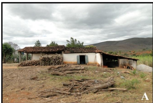
Figura 3A - Alambique do distrito de Casa de Telha, Rio de Contas (BA)
