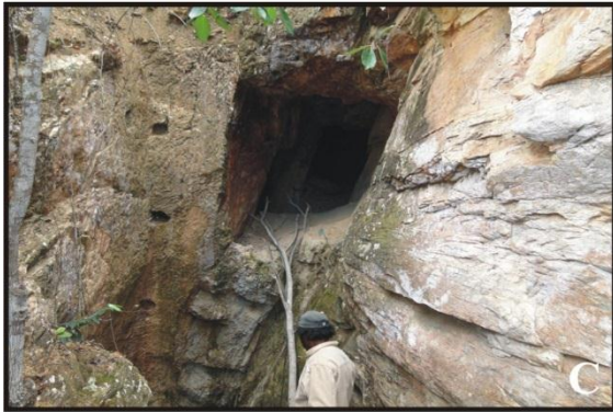
Figura 36C- Galeria superior escavada na encosta do Garimpo do Pereira, Rio de Contas, BA Figure 36C- Upper gallery excavated on the slope of the Garimpo do Pereira, Rio de Contas, BA. Foto: Violeta de Souza Martins, 2015.
