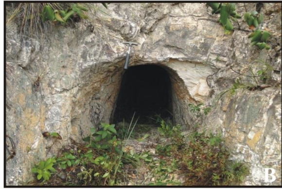
Figura 38B - Entrada da galeria do garimpo escavada nos metarenitos, Rio de Contas, BA Figure 38B - Entrance of the gallery of the garimpo excavated In the metasandstone, Rio de Contas, BA Foto: Violeta de Souza Martins, 2016
