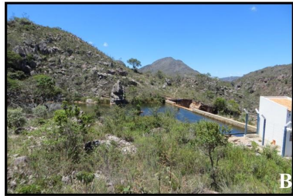
Figura 47B- Represa construída na trilha da Cachoeira do Mocotó, Rio de Contas, BA
