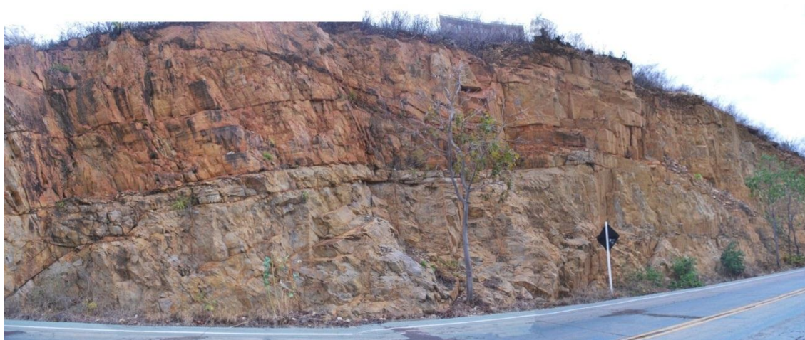
Figura 25 - Estratificação cruzada de grande porte em corte da Estrada Parque.
