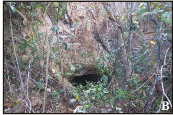
Figura 37B- Galeria do garimpo da Olaria parcialmente obstruída, Rio de Contas, BA
