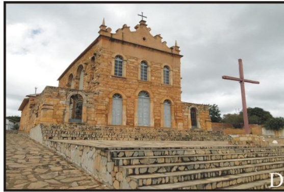
Figura 68D- Igreja de Senhora Santana, construída de metarenitos, Rio de Contas, BA
