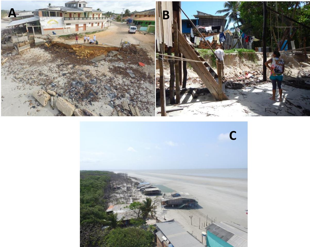
Figura 43- (A) Destruição de construções e de rua beira-mar na praia do Crispim, em 2016 (Fonte: LGA). (B) Construções expostas aos agentes costeiros devido variação da linha de costa, em 2016. (C) Edificações localizadas no ambiente praiial, expostas à ação das ondas e marés, em 2017.
