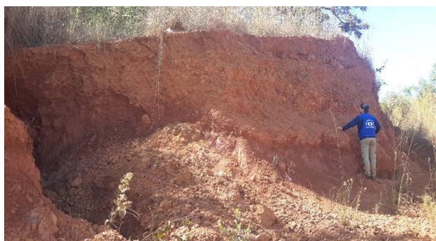
Figura 3.23: Imenso pacote de crosta laterítica responsável pela sustentação do relevo na região nordeste do Distrito Federal. Foto: Arquivo do Projeto, 2018.
