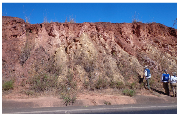
Figura 3.52: Processo erosivo formando sulcos sobre metassiltitos muito alterados. Rodovia DF-290. Gama-DF. Foto: Arquivo do Projeto, 2018.
