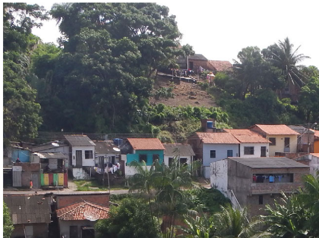
Figura 3.87: Área de risco muito alto a deslizamento, caracterizada por ocupações de moradias de alvenaria e madeira no topo e na base de um tabuleiro dissecado, com declividade acima de 45°, constituído por cascalho laterítico, e com presença de cicatrizes de deslizamento. São Luís-MA. Foto: Arquivo do Projeto Geodiversidade da Ilha do Maranhão (2018).
