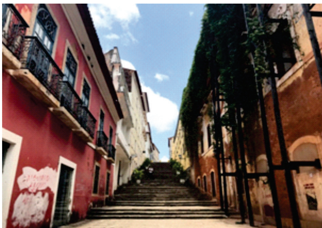
Figura 3.35: Foto da rua do Giz, com estrutura urbana sobre relevos colinosos no Centro Histórico de São Luís Fonte: viajento.com
