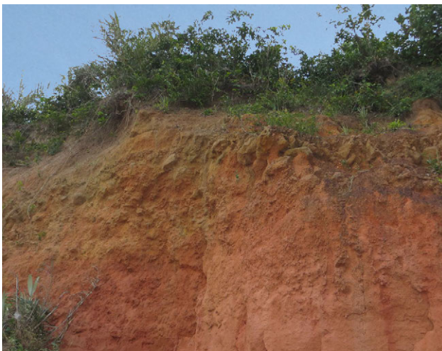
Figura 3.9: Crosta laterítica com estrutura colunar bem preservada, com canais preenchidos por material areno-argiloso, gradando para um Argissolo. Falésia da Praia de Panaquatira/Praia da Ponta Verde/São José de Ribamar. Foto: Arquivo do Projeto Geodiversidade da Ilha do Maranhão (2018).
