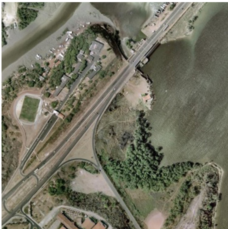
Figura 3.52: Situação da Barragem do Bacanga (São Luís) em 2008, já com forte ocupação de entorno e com problemas de funcionamento e manutenção. Escala original em 1:2.000. Fonte: PMSL (2008 apud DIAS, 2015).
