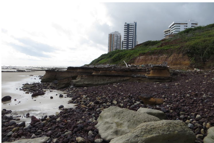
Figura 3.89: Falésia de aproximadamente 18 m de altura sustentada por material sedimentar, representado por siltitos com estratificação acanalada, intercalados com argilitos cinza e calcarenitos bem resistentes, gradando para um saprólito com camadas métricas medianamente resistentes de arenito, interdigitado com camadas argilo-siltosas. Este material está sob ação de ondas, que propiciam que o mesmo seja erodido. Praia Ponta da Areia, município São Luís – MA. Foto: Arquivo do Projeto Geodiversidade da Ilha do Maranhão (2018).
