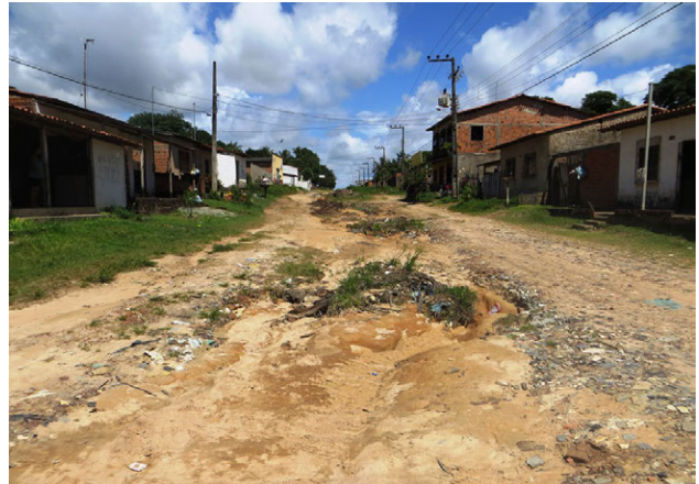
Figura 3.78: Área suavemente ondulada associada a solo de textura areno-argilosa de cor amarelada (Argissolo), apresentando feições erosivas. Área em processo de expansão urbana. Avenida Dois, município São José do Ribamar – MA. Foto: Arquivo do Projeto Geodiversidade da Ilha do Maranhão (2018).
