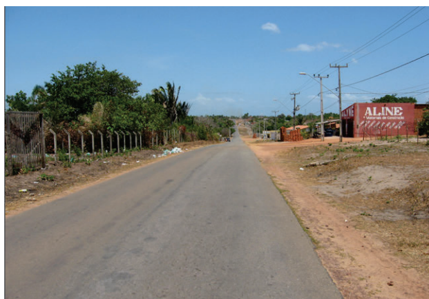
Figura 3.50: Área urbana de baixa densidade, nas margens da estrada de Panaquatira, município de São José de Ribamar-MA. Foto: Arquivo do Projeto Geodiversidade da Ilha do Maranhão (2018).
