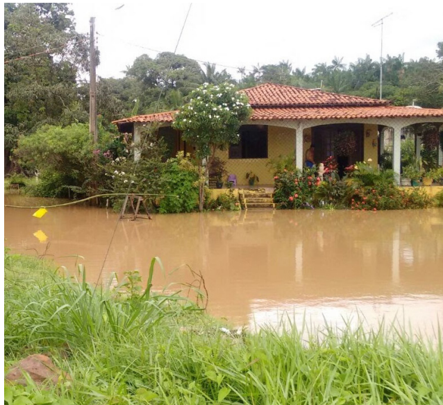
Figura 3.18: Área de risco alto à inundação, caracterizada por oito casas construídas nos depósitos aluvionares do Rio Paciência - Bairro Maioba, município Paço do Lumiar - MA. Foto: Arquivo do Projeto Geodiversidade da Ilha do Maranhão (2018).
