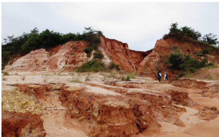
Figura 3.90: Área de extração de areia, onde foi retirada a cobertura laterítica, propiciando a instalação de processos erosivos (sulcos e ravinas) nas camadas subjacentes de textura mais arenosa. Próximo à Avenida Engenheiro Emiliano Macieira, município São Luís – MA. Foto: Arquivo do Projeto Geodiversidade da Ilha do Maranhão (2018).
