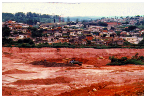
Figura 28 - Aspectos de preparação de área do Aterro Sanitário de Bandeirantes.
