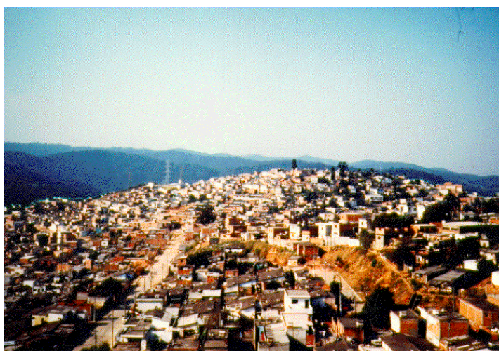
Figura 55 -Aspectos de ocupação em área de potencialidade alta de ocorrência de escorregamento no bairro Brasilândia (Zona Norte de São Paulo). Notar corte em talude realizado para possibilitar o arruamento, porção inferior direita da foto. Ao fundo notar forma de relevo de morros ainda não ocupados, marcando os limites da expansão urbana atual.
