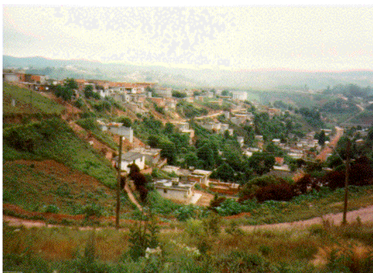
Figura 54 -Aspectos de ocupação em área de potencialidade alta de ocorrência de escorregamento na região de Franco da Rocha. Ocupação em encostas de vale encaixado.
