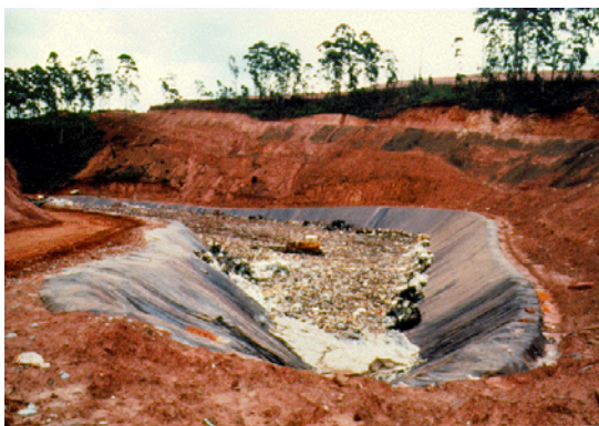
Figura 30 - Aspectos de preparação de área para o Aterro Sanitário de Bandeirantes. Notar a lona plástica utilizada para impermeabilização.
