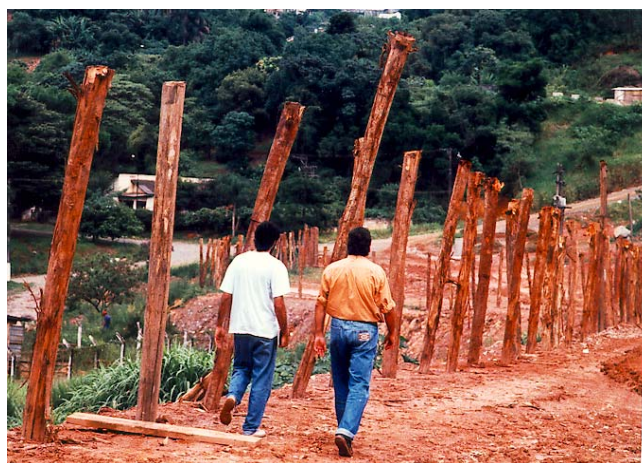
Figura 36 - Medida de segurança contra efeitos de escorregamento feita com estacas de eucalipto cravadas, à jusante do Aterro Sanitário de Vila Albertina. Notar habitações à esquerda da foto.
