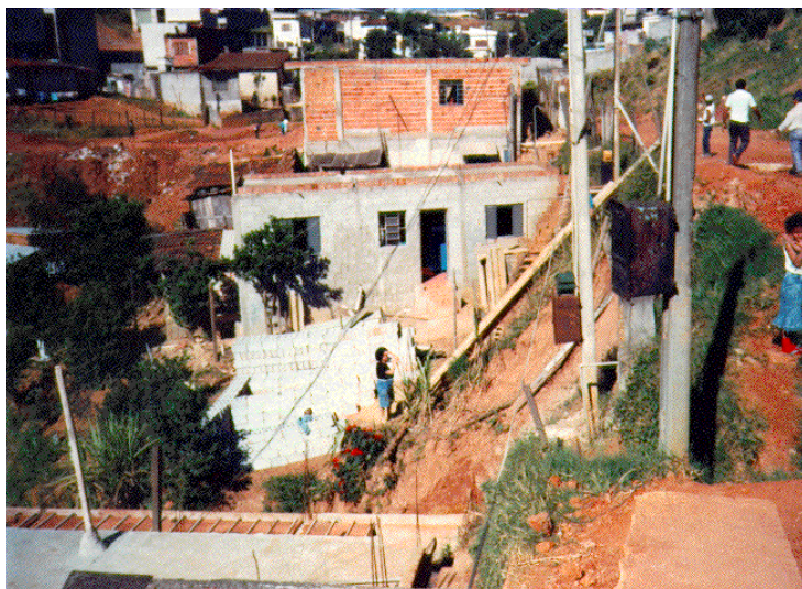
Figura 53 -Aspectos de ocupação em área de potencialidade alta de ocorrência de escorregamento no bairro de São Mateus, Zona Leste de São Paulo. A adequação do terreno íngreme para sua ocupação é realizada através de cortes e aterros.
