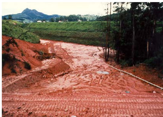
Figura 29 - Aspectos de preparação de área para o Aterro Sanitário de Bandeirantes. Notar assoreamento da drenagem à jusante. Ao fundo vê-se o Pico do Jaraguá.
