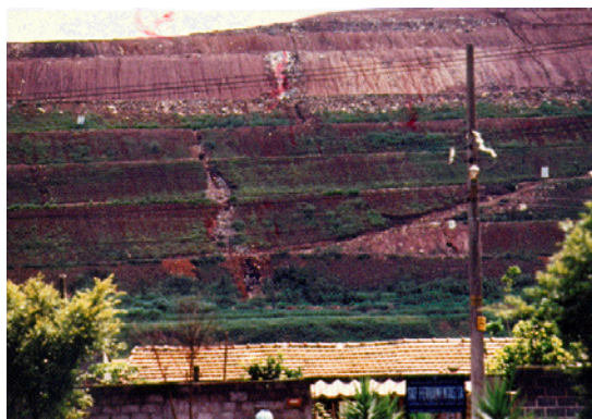
Figura 31 - Aspectos de aterro sanitário em operação. Aterro Sanitário de Santo Amaro. Notar os drenos para águas pluviais e para o escape de gases.
