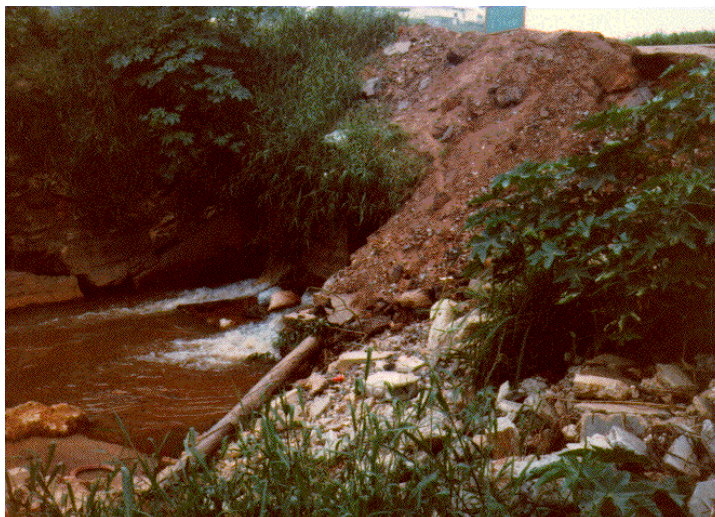
Figura 58 - Estrangulamento de canal de córrego próximo a Av. dos Sertanistas, na Zona Leste de São Paulo, dificultando o escoamento das águas. Problemas desta natureza são típicos da forma de ocupação da Região Metropolitana de São Paulo, ocasionando incremento da potencialidade natural de inundações junto às drenagens.
