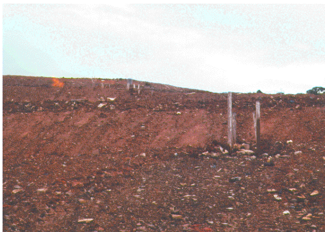
Figura 35 - Marcos topográficos no Aterro Sanitário de Vila Albertina que chegaram a migrar até 1m no intervalo de uma semana.
