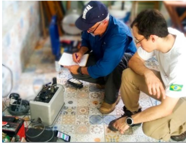
Figura 04: Técnicos da UFRN e CPRM fazendo a instalação dos sismógrafos no bairro Pinheiro.
