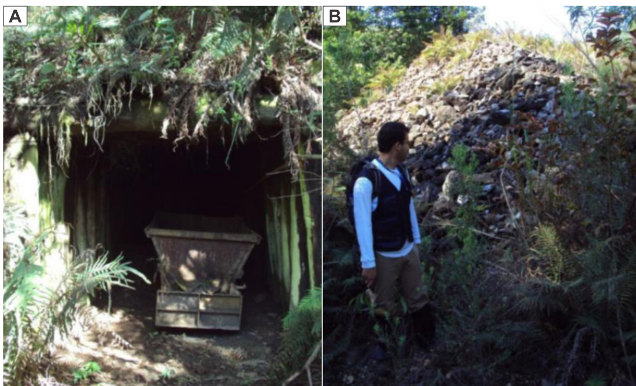
Figura 5.8. A) Entrada de antiga galeria, na região da mina do Perau, com desabamento. B) Pilha de rejeito e/ou material de baixo teor extraído na região da Mina do Perau. Fotografias: a - Anderson Dourado Rodrigues da Silva e B - Mariane Brumatti, 2016
