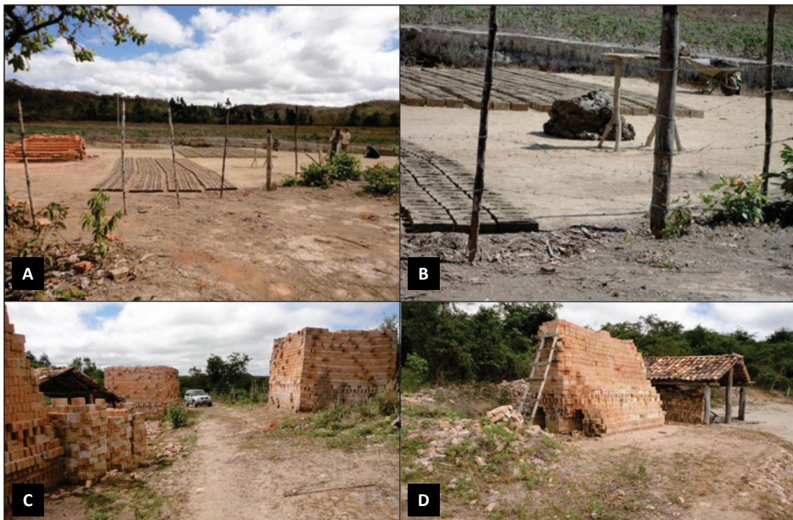
Figura 6.1 - A) Secagem de tijolo após confecção manual, ponto SQ-320. B) Argila sendo moldada em formas manualmente e posteriormente secagem ao sol, ponto SQ-320. C) Empilhamento dos tijolos de argila, ponto SQ-331. D) Empilhamento e queima dos tijolos, ponto SQ-331.
