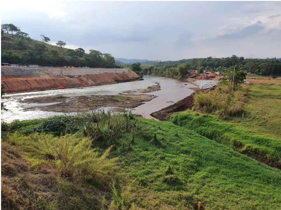
Foto 4-4 – Remoção Mecânica do Rejeito Depositado no Leito do Rio Paraopeba (15/10/2020)
