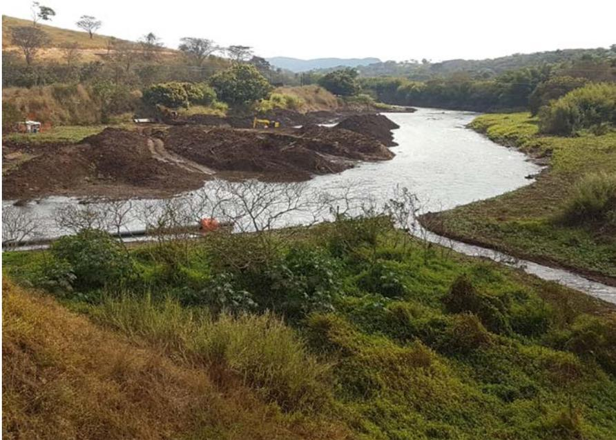
Foto 4-3 – Remoção Mecânica do Rejeito Depositado no Leito do Rio Paraopeba (08/08/2019)
