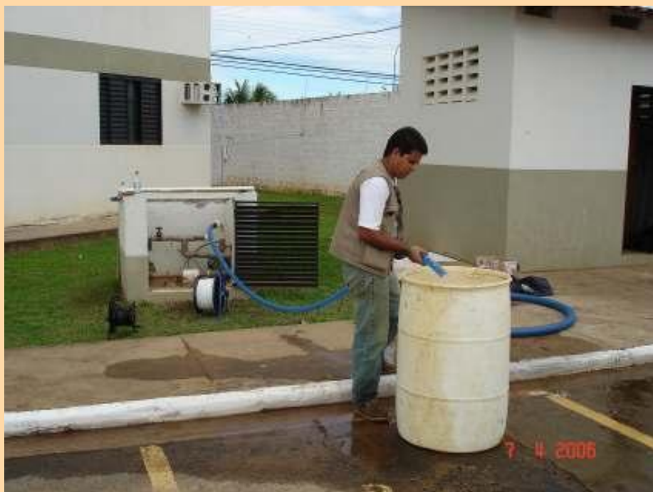
Fotografia 3: Teste de bombeamento realizado na vila da Amizade, condomínio Vilacre.
