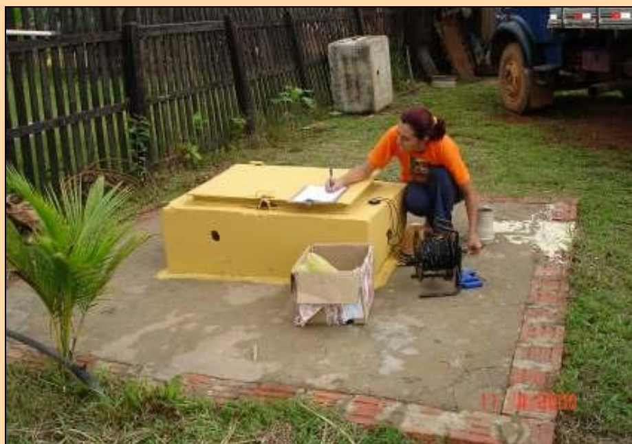
Fotografia 1: Teste de bombeamento realizado no ramal da Judia.
