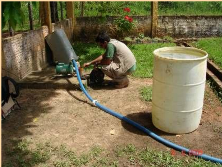
Fotografia 2: Teste de bombeamento realizado na estrada do Amapá.
