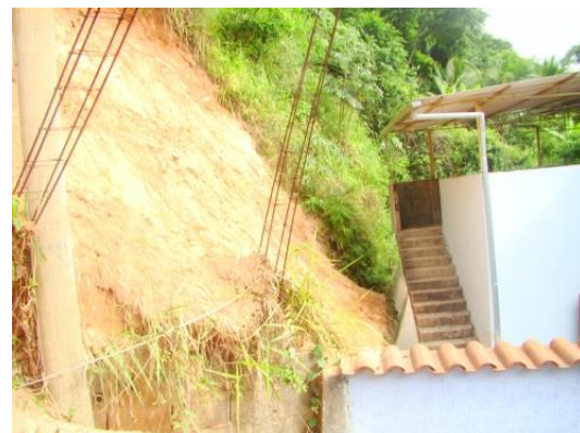
Figura 48: Deslizamento planar de solo que atingiu a lateral da construção.
