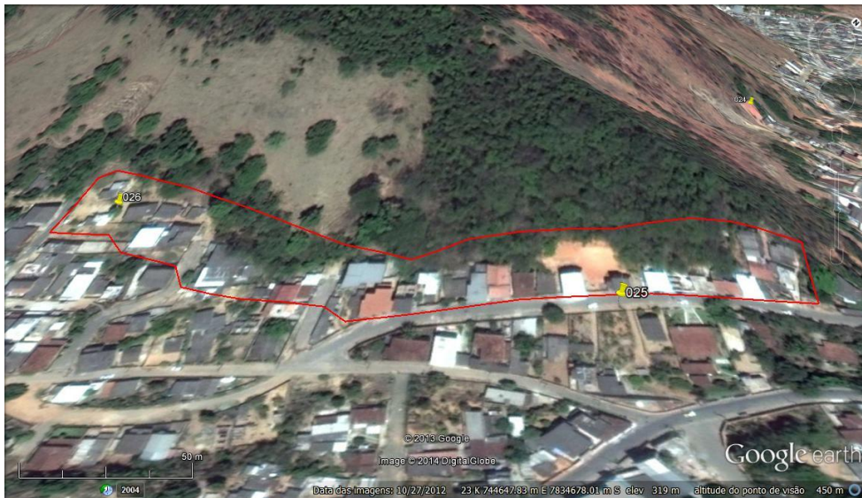
Figura 35: Delimitação da área com risco geológico (Imagem: Google Earth).
