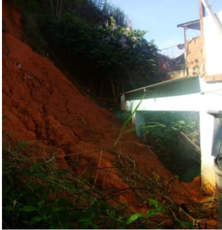
Figura 7: Deslizamento planar de solo.
