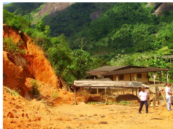
Figura 16: Deslizamento planar de solo que atingiu uma casa.
