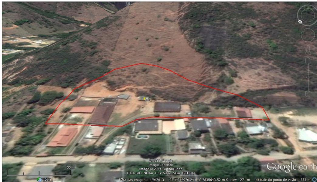
Figura 14: Delimitação da área com risco geológico (Imagem: Google Earth).
