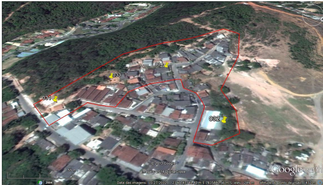
Figura 43: Delimitação da área com risco geológico (Imagem: Google Earth).
