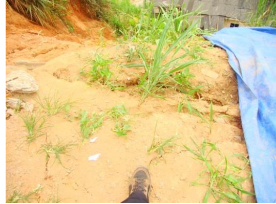
Figura 51: Trincas no terreno.
