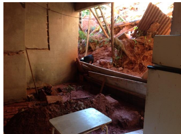
Figura 40: Construção afetada pelo deslizamento.
