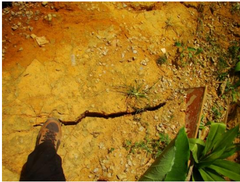
Figura 75: Trincas no terreno.
