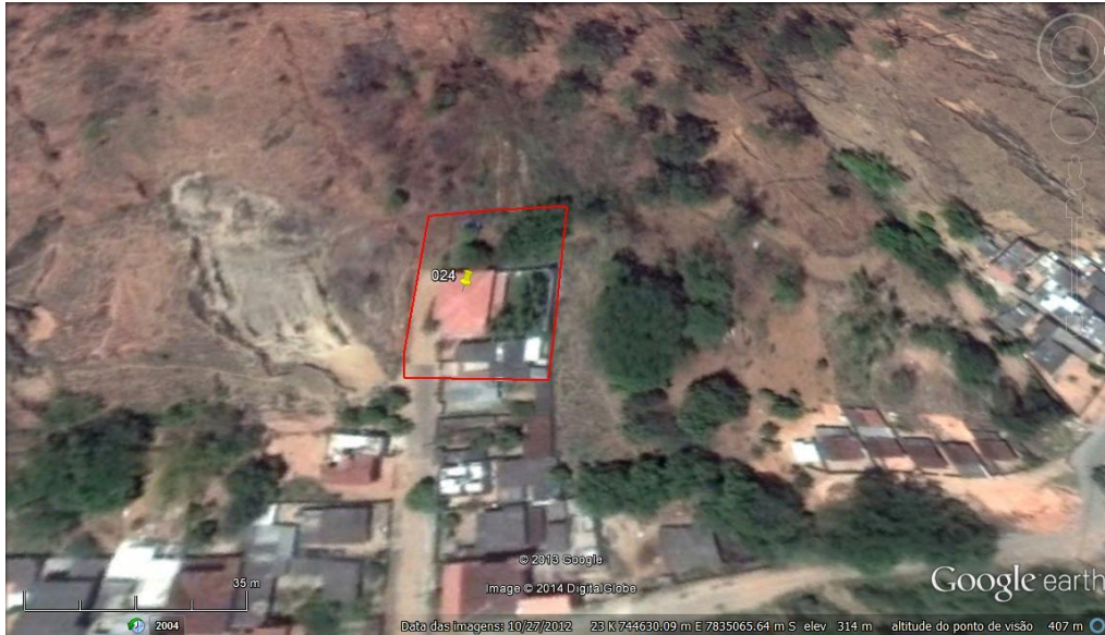
Figura 32: Delimitação da área com risco geológico (Imagem: Google Earth).
