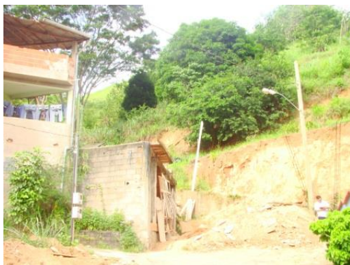
Figura 47: Deslizamento planar de solo.
