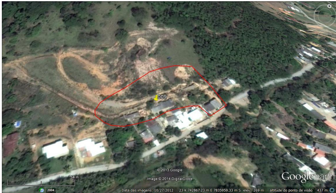
Figura 11: Delimitação da área com risco geológico (Imagem: Google Earth).
