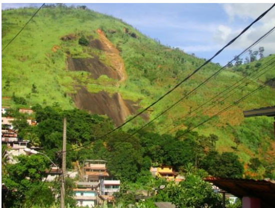
Figura 4: Blocos que podem rolar do alto da encosta.
