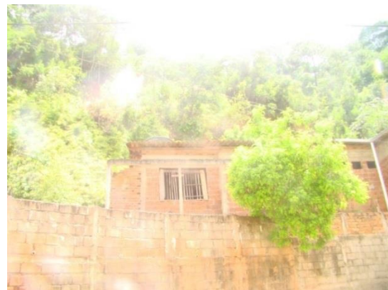
Figura 62: Visão do talude situado atrás da moradia.
