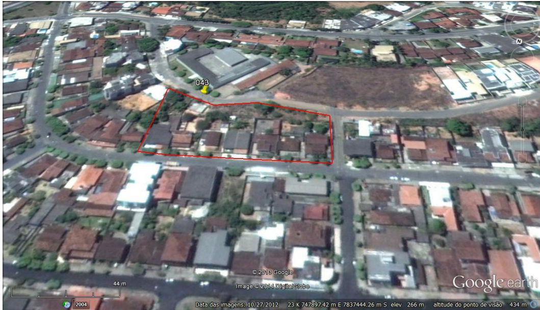
Figura 55: Delimitação da área com risco geológico (Imagem: Google Earth).
