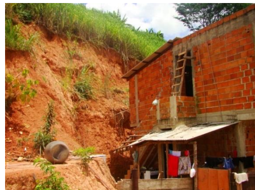
Figura 71: Deslizamento de solo que atingiu casa.
