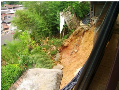
Figura 67: Destruição parcial de moradia provocada por deslizamento.
