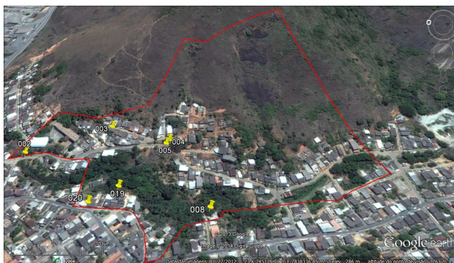
Figura 1: Delimitação da área com risco geológico (Imagem: Google Earth).
