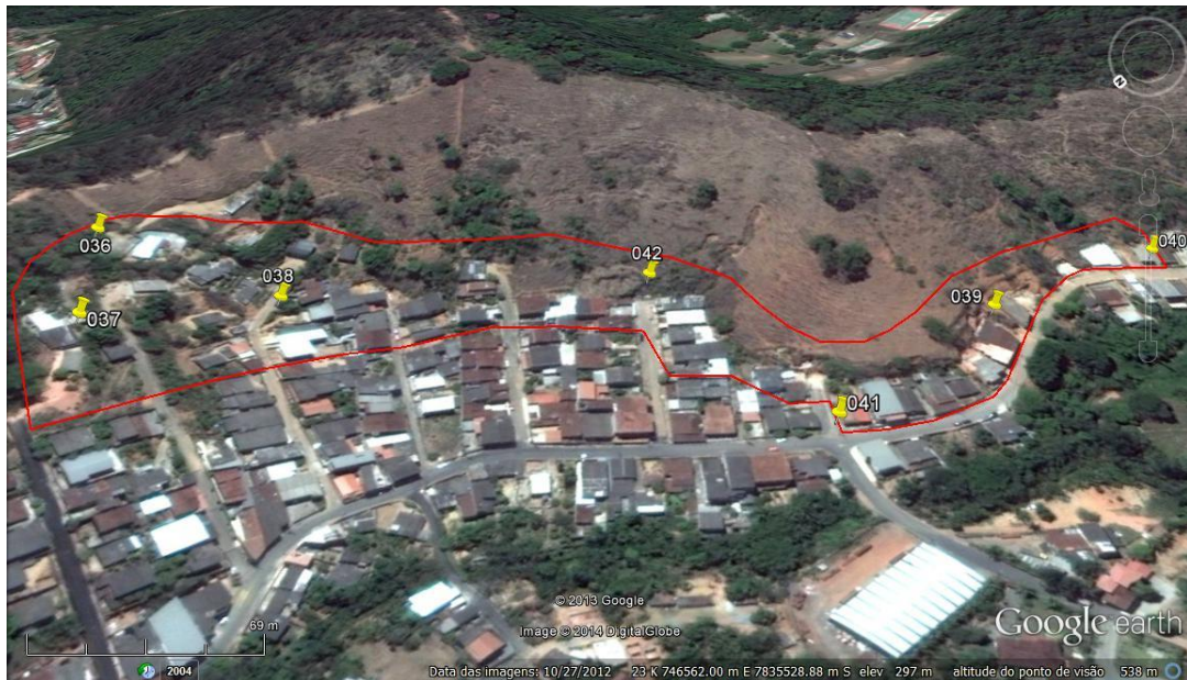
Figura 49: Delimitação da área com risco geológico (Imagem: Google Earth).
