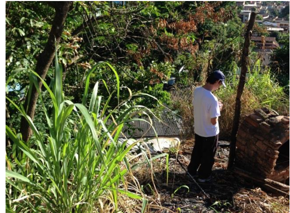
Figura 31: Casa que corre risco de ser atingida por deslizamento.
