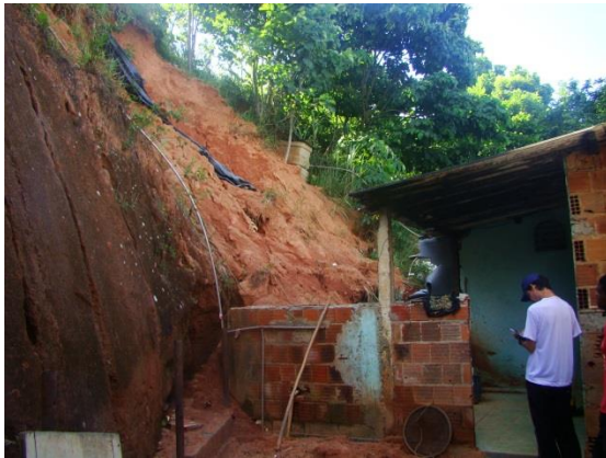
Figura 9: Deslizamento planar de solo.
