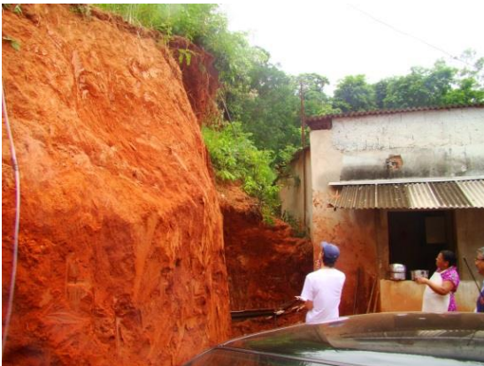
Figura 52: Deslizamento de solo.
