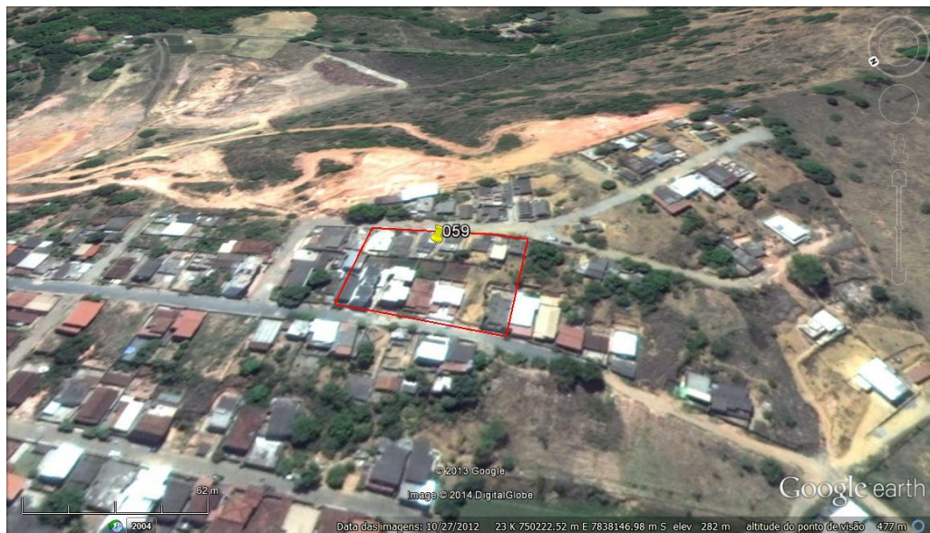
Figura 74: Delimitação da área com risco geológico (Imagem: Google Earth).
