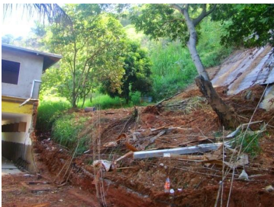
Figura 33: Deslizamento translacional que atingiu a moradia.
