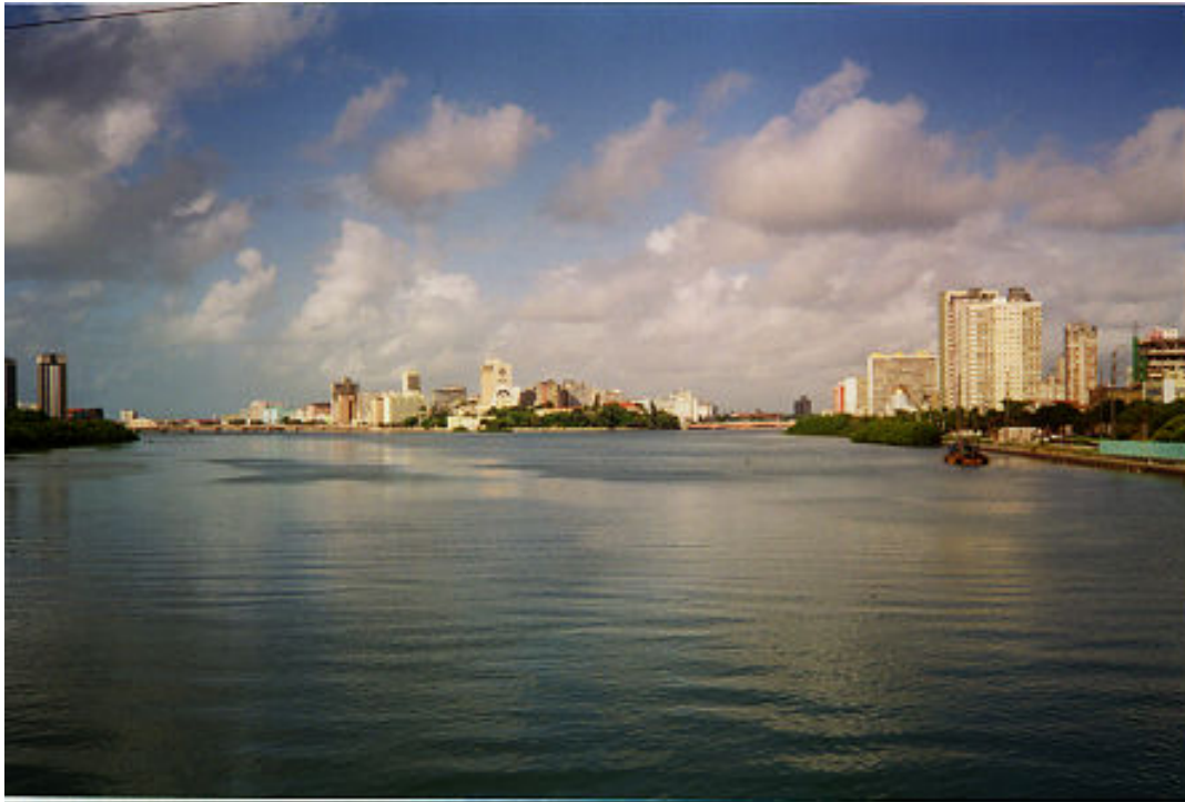
Foto 5.3 - Rio Capibaribe - Boa Vista - Recife - PE
