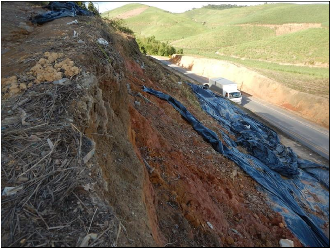
Foto 19: Lonas plásticas usadas como proteção provisória ao talude em risco de deslizamento, às margens da rodovia PE-063. Observe-se que as lonas plásticas necessitam ser substituídas, pois já não são efetivas, e é recomendável estudos de engenharia civil geotécnica para propor uma solução adequada para esta encosta.
