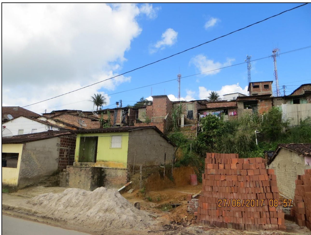
Foto 09: Encosta estruturada em patamares de corte e aterro, densamente povoada. A ausência de um sistema de drenagem e de saneamento básico induz saturação do solo por umidade, a qual favorece deslizamentos.
