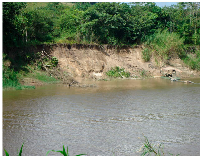
Figura 6.3 - Dragagem muito próxima a margem, aumentando o deslizamento dos sedimentos das encostas, Depósitos fluviolagunares – Município de Rio Largo/AL (Afloramento KC 070). Fonte: Klaryanna Cabral Alcantara, 2018.
