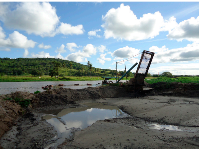
Figura 4.7 - Extração de areia no leito ativo do Rio Mundaú. Depósitos Fluviolagunares – Satuba/AL (Afloramento KC 084). Fonte: Klaryanna Cabral Alcantara, 2018.
