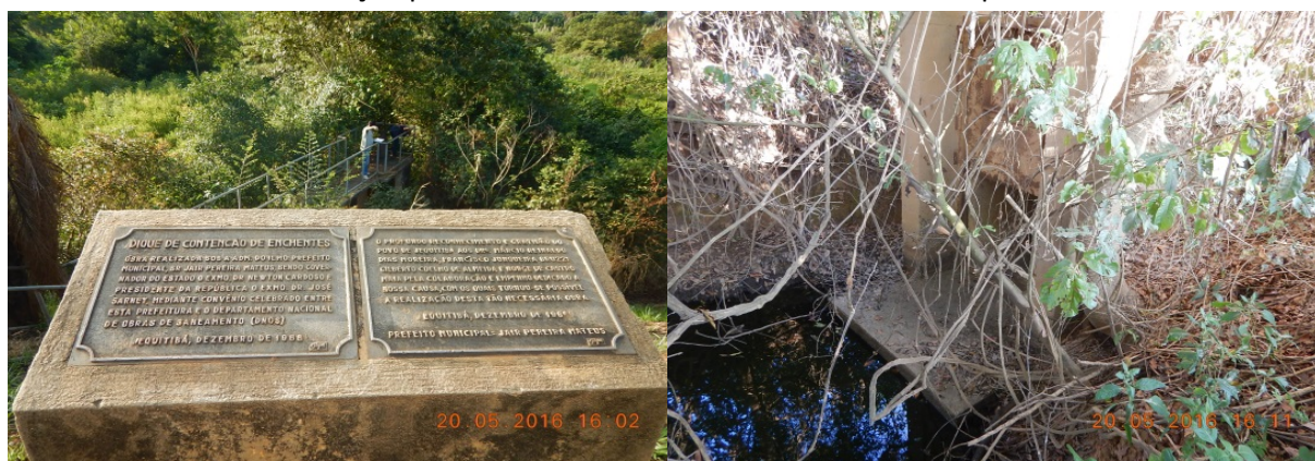
Topo e dreno de pé do dique da cidade de Jequitibá
