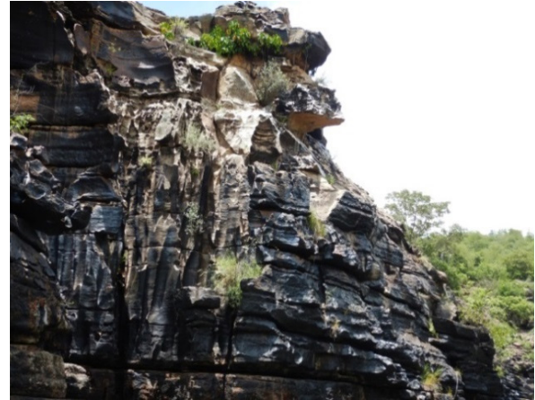
Figura 72 - Encosta sob forte ação erosiva da água e com sinais de quedas de blocos recentes por cicatrizes sem alteração química pela água. Observar blocos com instabilidade muito alta no topo.
