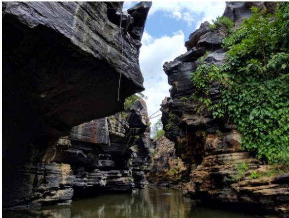
Figura 80 - Encosta com planos verticais e horizontais de instabilização, cicatrizes de queda de blocos e outros tanto sem sustentação presentes na porção média e base. Muitos blocos soltos no topo zona de quebra de relevo da encosta.
