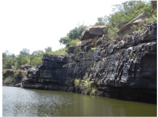
Figura 61 - Marcar erosivas por ação da água no corpo da encosta que apresenta, ao longo de toda a extensão superior, presença de blocos instáveis rolados dos patamares anteriores ao vértice do paredão.
