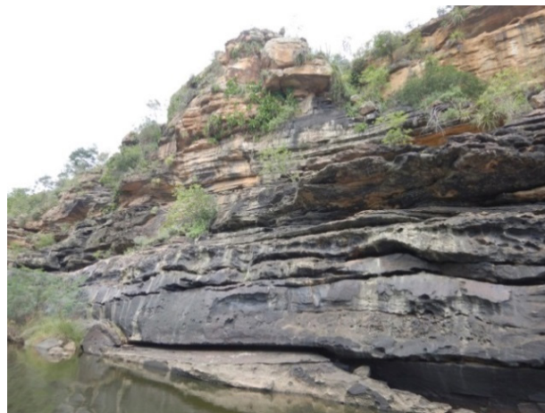
Figura 34 - Encosta com blocos instáveis no topo e sinais indicativos de forte alteração erosiva ao longo de camadas mais frágeis. Camadas dos ritmitos da base com processos de deslocamento.
