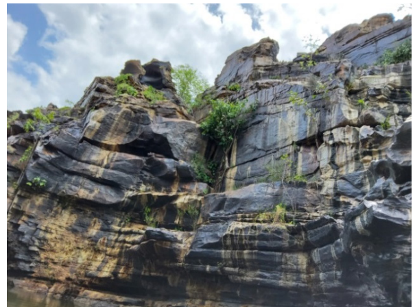
Figura 66 - Encosta com evidentes sinais da ação erosiva da água, alargando as fraturas e movimentando o material mais fino das descontinuidades com tendência a instabilização das camadas tabulares.
