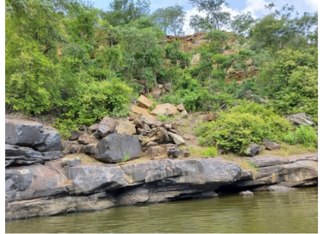
Figura 14 - Individualização de prismas com material alterado nas descontinuidades e rolamento de blocos.
