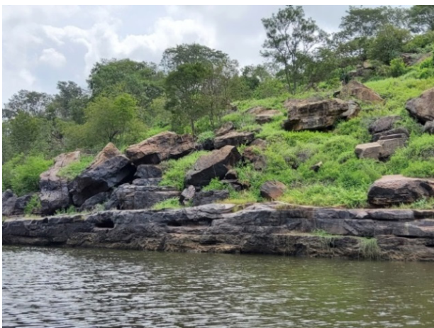
Figura 18 - Encosta com inclinação baixa mas fortes sinais de movimentação de blocos.
