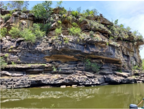
Figura 63 - Paredão de forte inclinação com fraturas verticais e horizontais definindo prismas rochosos suscetíveis a movimentação. Presença de blocos instáveis e em balanço por toda a porção superior da encosta.
