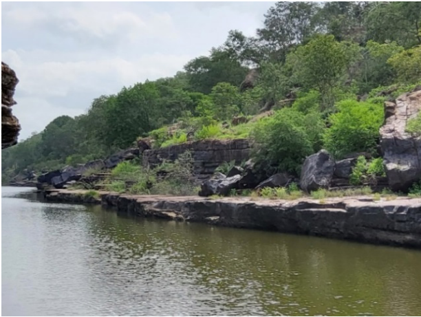
Figura 21 - Ritimitos basais, fraturados e presença de blocos roladas das camadas superiores. Presença de descontinuidades estruturais com sinais de intemperismo químico (decomposição).
