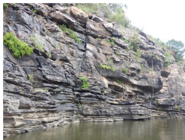
Figura 74 - Encosta fortemente tectonicizada com sets de fraturas fechadas da base ao topo responsáveis pela movimentação e instabilização de blocos no topo.
