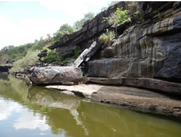
Figura 45 - Encosta íngreme com sinais de movimentação de massa por deslocamento, quedas e deslizamento de blocos.
