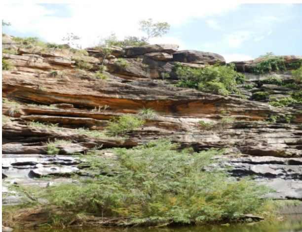
Figura 33 - Encosta íngreme, fortemente alterada, com relevo negativo ao longo de todo o paredão e blocos no topo descalçados em forte condição de instabilidade.
