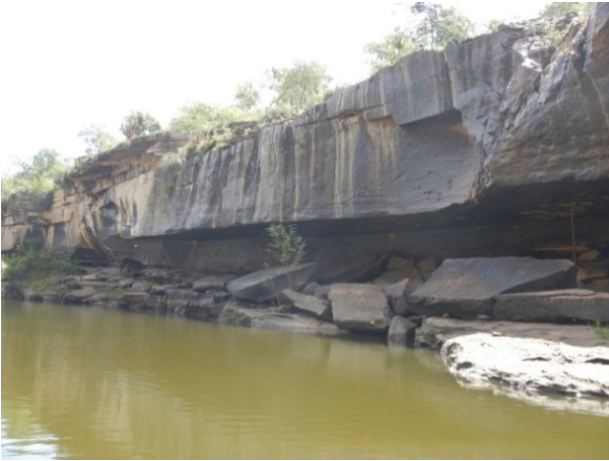
Figura 41 - Paredão com blocos em balanço, forte deslocamento de grandes blocos com feições de “casa de pedra” ao longo de grande extensão da porção basal.
