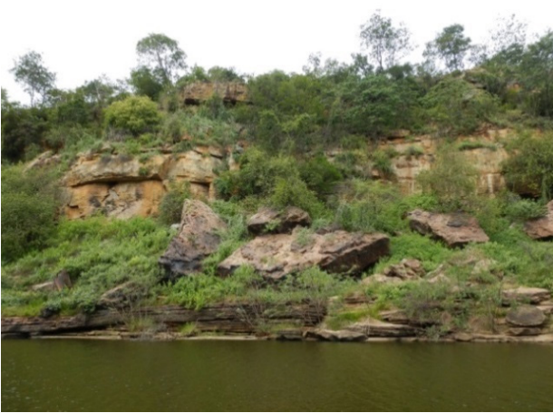
Figura 30 - Encosta movimentada com blocos em balanço e contatos entre camadas alterados, potencializando movimento de massa..
