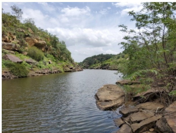
Figura 24 - Encosta com indicativos de significativa movimentação de blocos, com fraturas verticais e horizontais, estas favorecendo a alteração da rocha nas discontinuidades.
