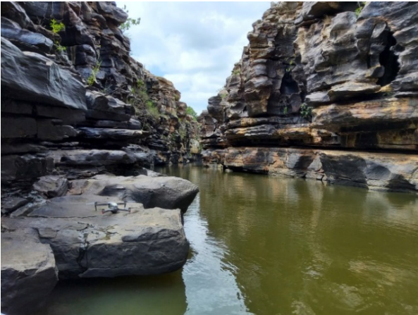
Figura 78 - Encosta íngreme com feições erosivas produzidas pela ação da água que escorre sobre o declive formando panelões e infiltra nas fendas decompondo camadas milimétricas de finos e instabilizando blocos fortemente fraturados.
