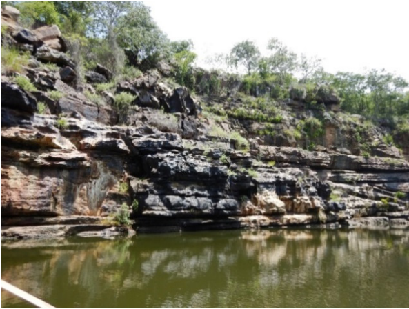
Figura 60 - Encosta com significativa individualização de prismas rochosos pelos sets de fraturas da base ao topo, com blocos instáveis e fortemente suscetíveis a movimentação.
