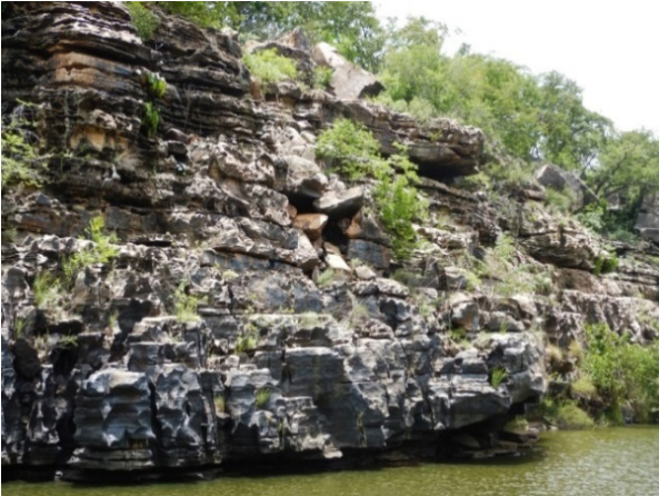
Figura 71 - Encosta fortemente tectonizada com sets de fraturas da base ao topo com movimentação ao longo das mesmas. Observar blocos instáveis no topo e na porção média da encosta para além de cicatriz de queda de bloco. Porção inferior da encosta sem sustentação na base.
