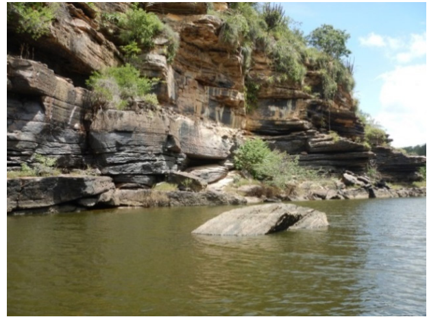
Figura 44 - Encosta com forte instabilidade de blocos, relevo negativo nos pontos de "casa de pedra", blocos tombados no leito do rio e na encosta.
