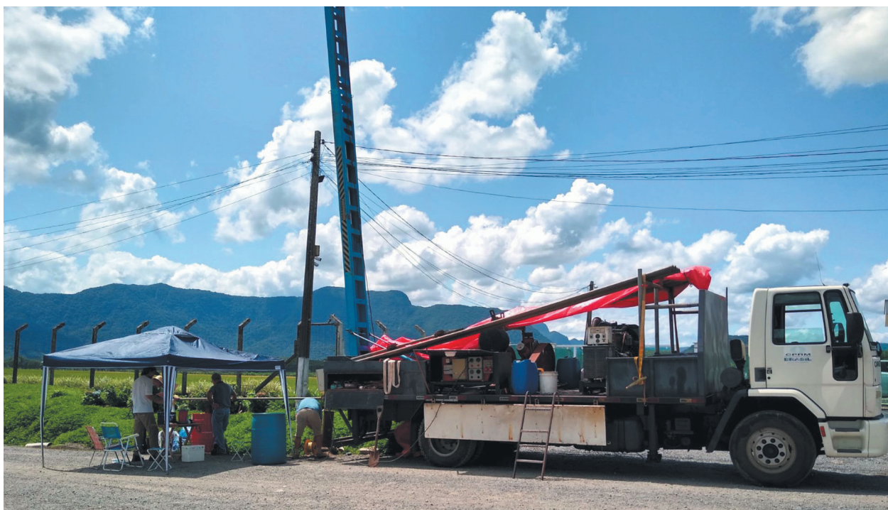
Figura 7.3. Veículo do SGB-CPRM equipado com grupo gerador, guincho e bomba submersa, utilizados para os ensaios de bombeamento em Joinville.
