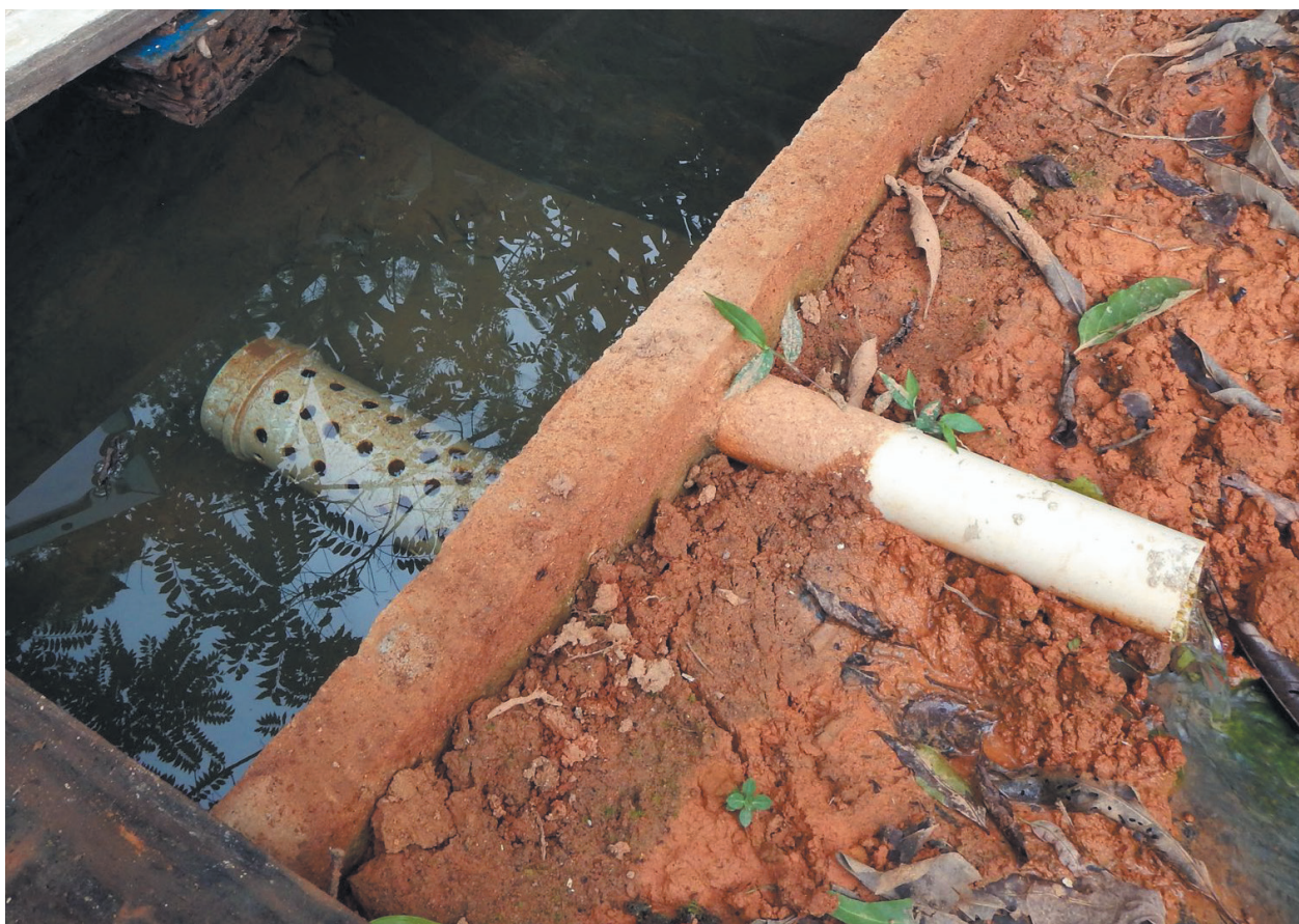
Figura 4.9. Exemplo de proteção e captação de fonte natural. A tampa foi retirada para exibição do interior da obra. Local: Sítio Big Valley-Estrada Bonita.
