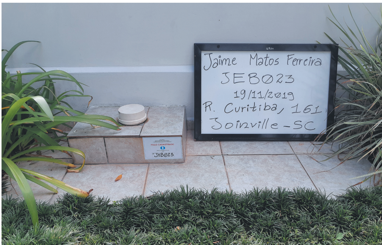
Figura 7.21. Poço de pequeno diâmetro em excelentes condições de proteção e operação.
