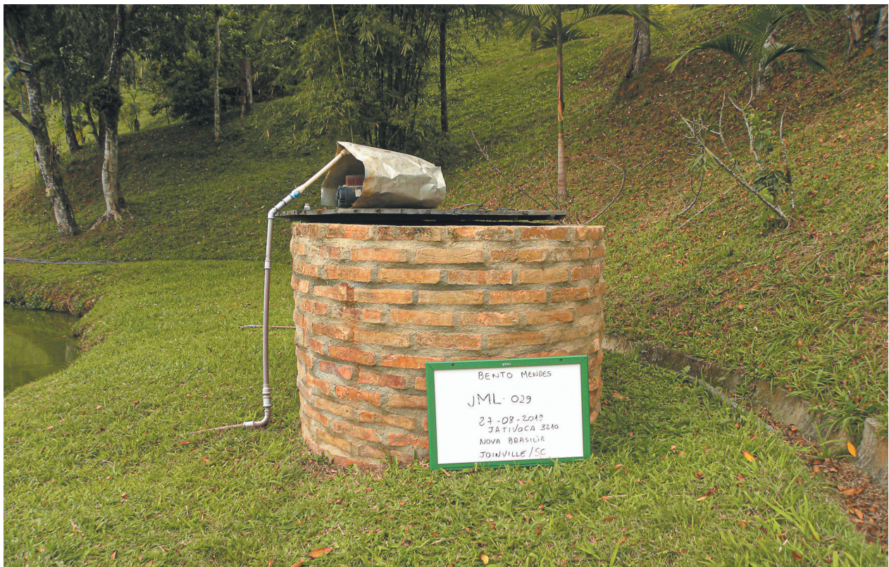
Figura 8.10. Vista lateral de poço escavado bem cuidado (ponto JML-029).
