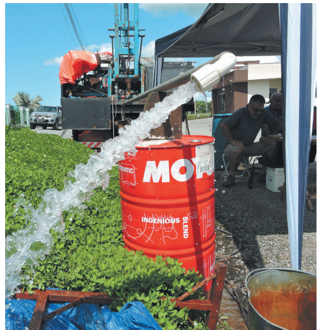
Figura 14 – Ensaio de bombeamento (bombeamento por 24 horas ininterruptas).
