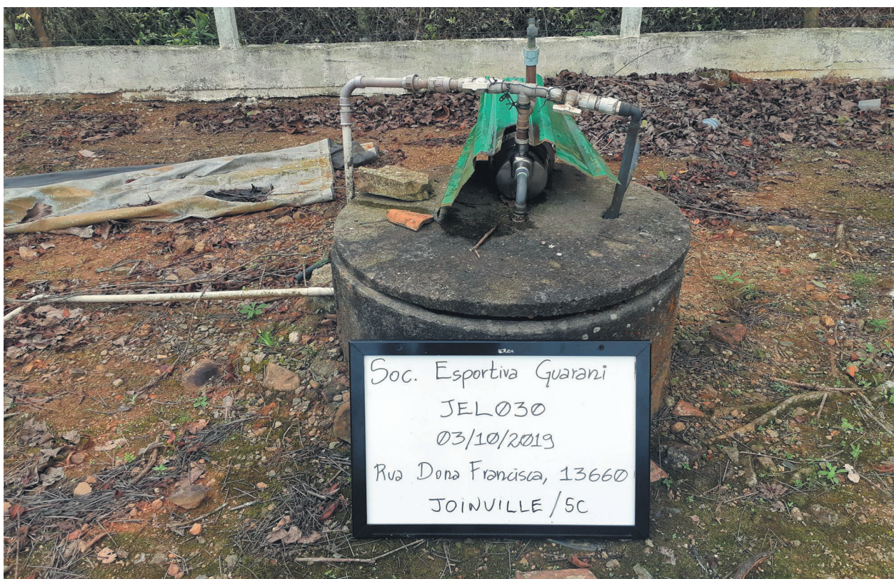
Figura 4.7. Poço escavado revestido com manilha de concreto e equipado com bomba de recalque.
