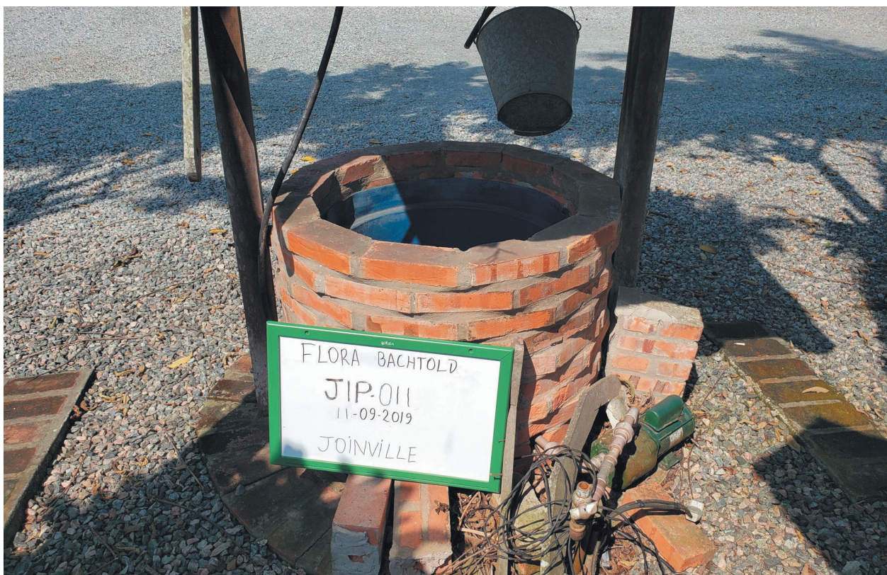
Figura 4.6. Poço escavado revestido com tijolos e equipado com sarilho para extração de água.
