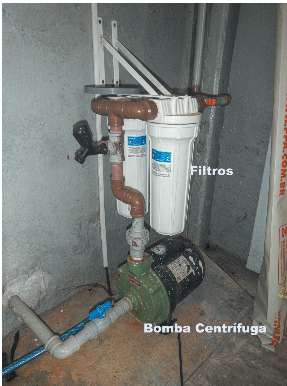
Figura 8.7. Utilização de filtros para diminuir a turbidez da água.
