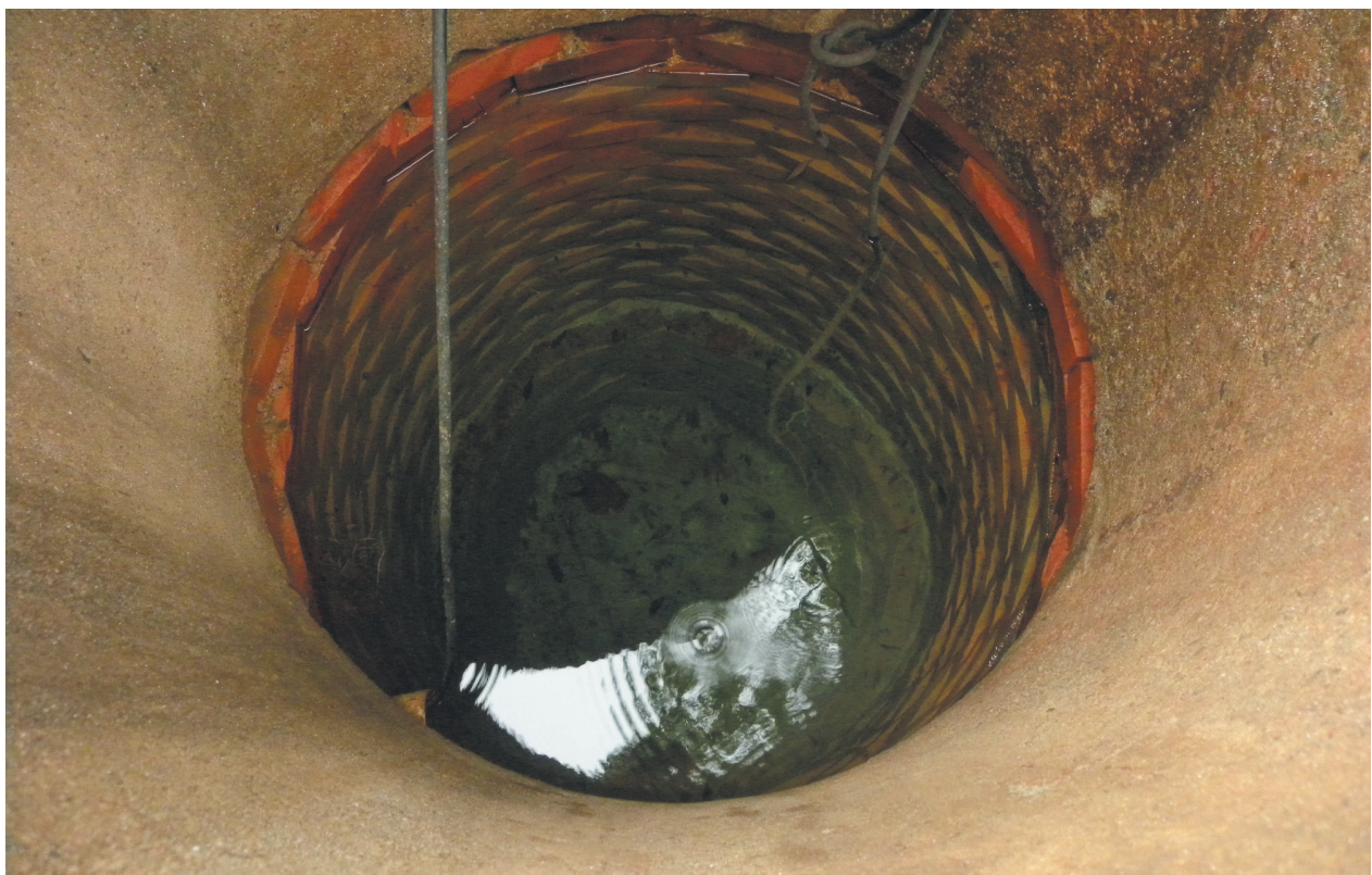
Figura 8.11. Vista do interior de poço escavado bem cuidado (ponto JML-029).
