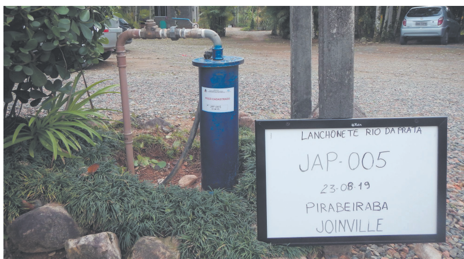
Figura 5.2. Esquema de identificação de ponto de captação de água subterrânea com adesivo resistente às intempéries e quadro branco em poço tubular na localidade de Pirabeiraba.
