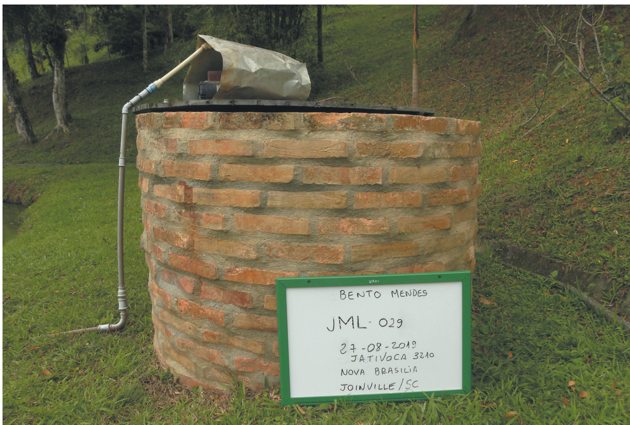
Figura 7 – Poço escavado construído com tijolos.
