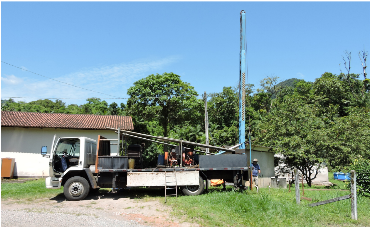
Figura 4.3 Ensaio de bombeamento no poço JAP007.
