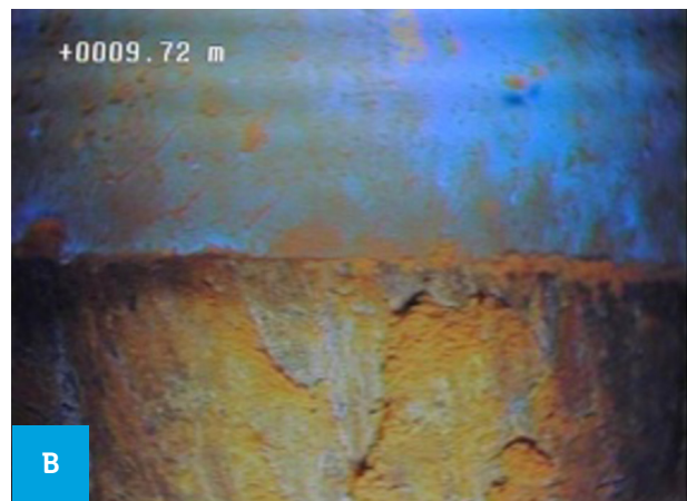
b) Contato revestimento x rocha
