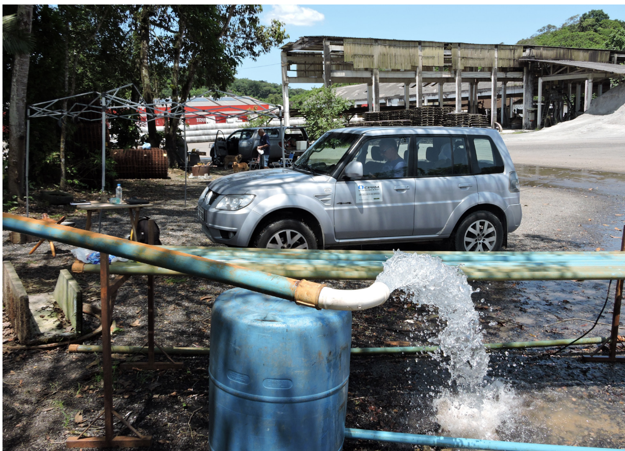
Figura 4.10 Teste de vazão executado no poço JML007.
