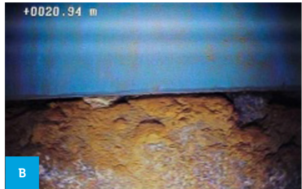
b) Contato revestimento x rocha
