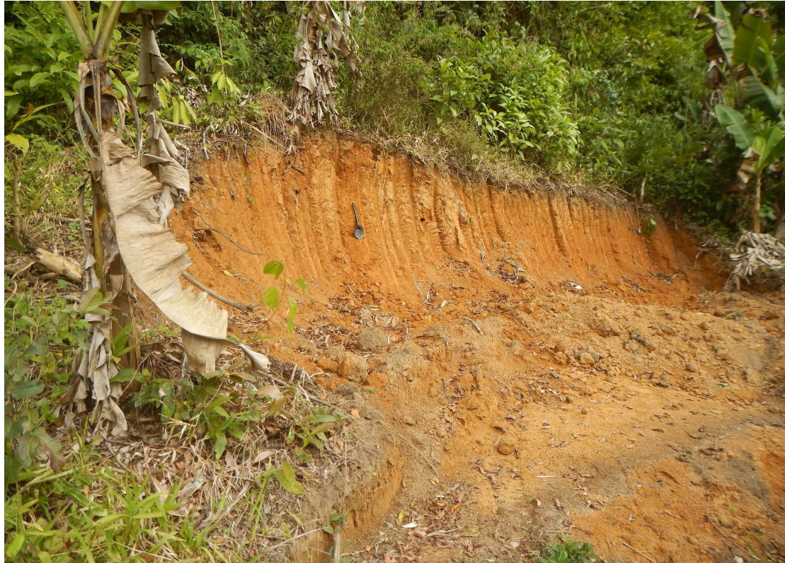
Figura 07 - Ponto de campo no. 5 – Talude de corte mostrando horizonte superficial do solo residual de gnaisses e/ou migmatitos.
