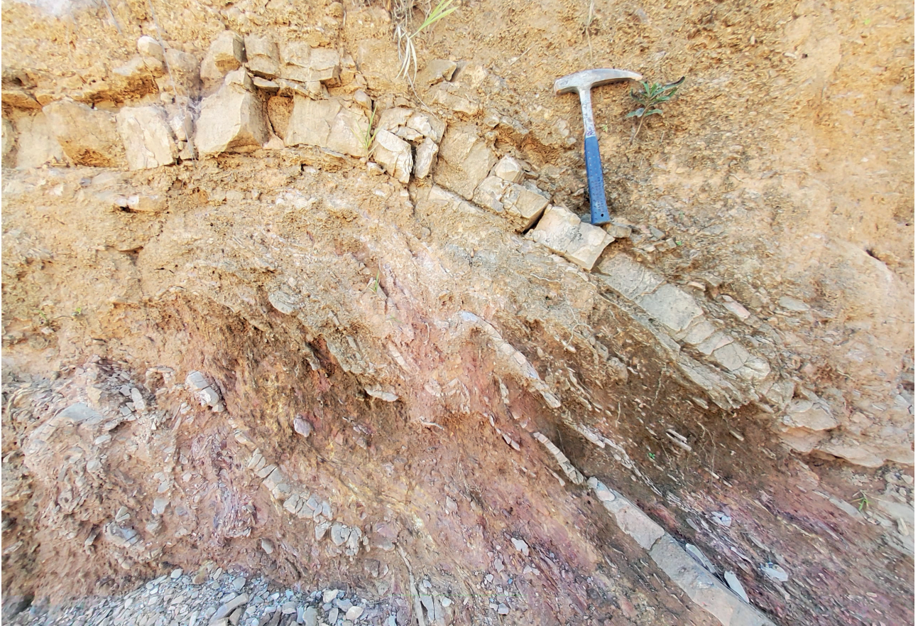
Figura 27 - Imagem exibindo a cobertura de solo residual, com seu horizonte saprolítico predominante, típico desta unidade.
