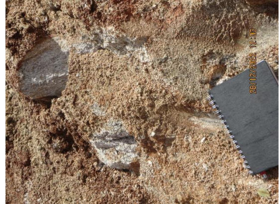
Figura 13. Detalhe de fragmentos de rocha gnáissica alterada encontrada na base da encosta que deslizou.
