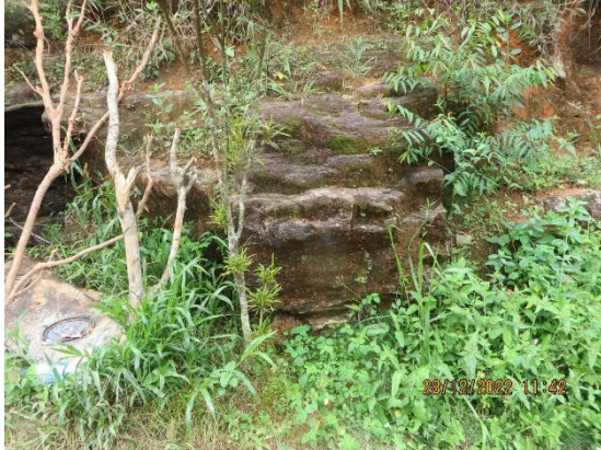
Figura 12. Aspecto da rocha gnaissica com bandamento horizontalizado, observado na base da encosta ao lado da casa que que foi danificada.
