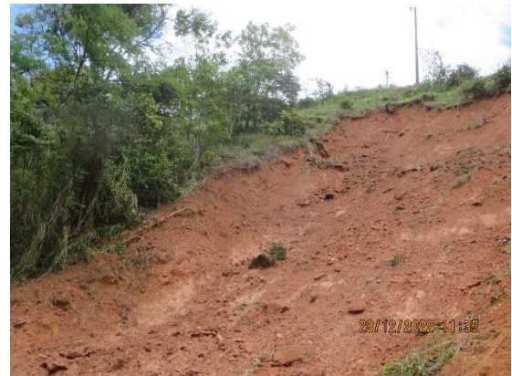
Figura 15. Detalhe da borda da cicatriz onde se observa a camada de solo coluvionar (mais escura) sobre o solo in situ (mais claro).
