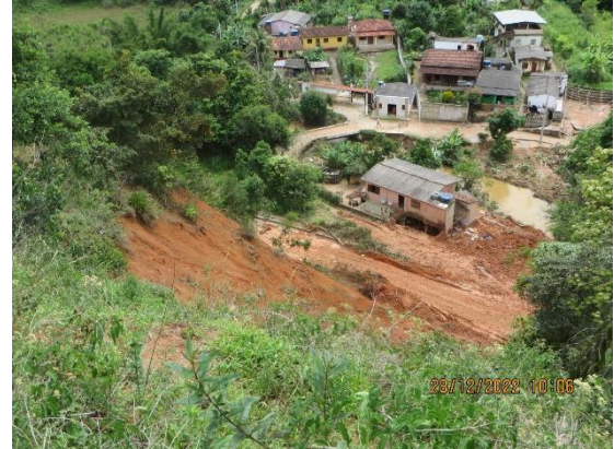
Figura 11. Posição das casas em relação à encosta de alta declividade onde ocorreram os deslizamentos. Notar o córrego a jusante.
