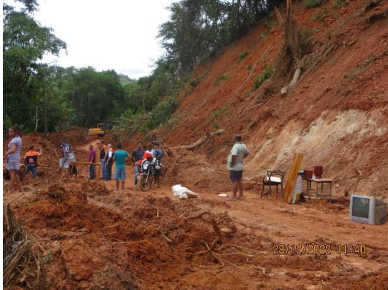
Figura 16. Aspecto do material deslizado com blocos de saprólito e restos da vegetação.
