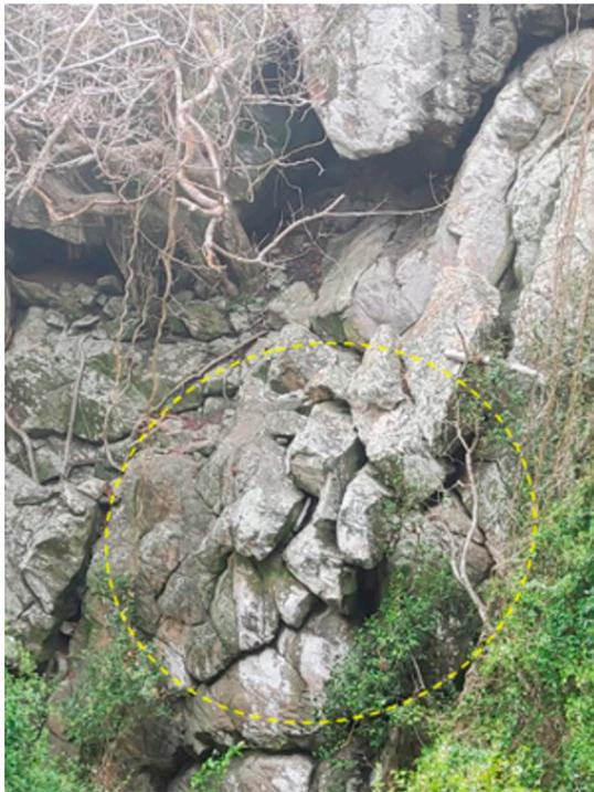
**Figura 78** - Paredão de rocha localizado na trilha em direção ao Piquinho. Notar blocos de rocha soltos, formados pelas estruturas em colunas que são típicas deste tipo de rocha. Foto: Autores.
