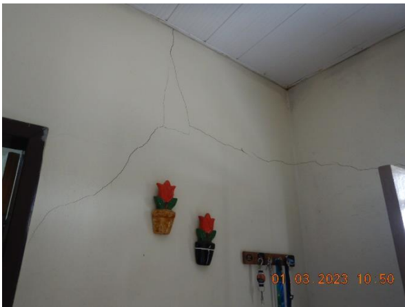
Figuras 5.3 e 5.4: Trincas nas paredes da residência de número 60 de possível causa construtiva
