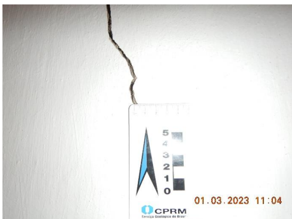
Figura 5.11: Rachadura interna aberta na residência. Figura 5.12: Rachadura aberta em muro
