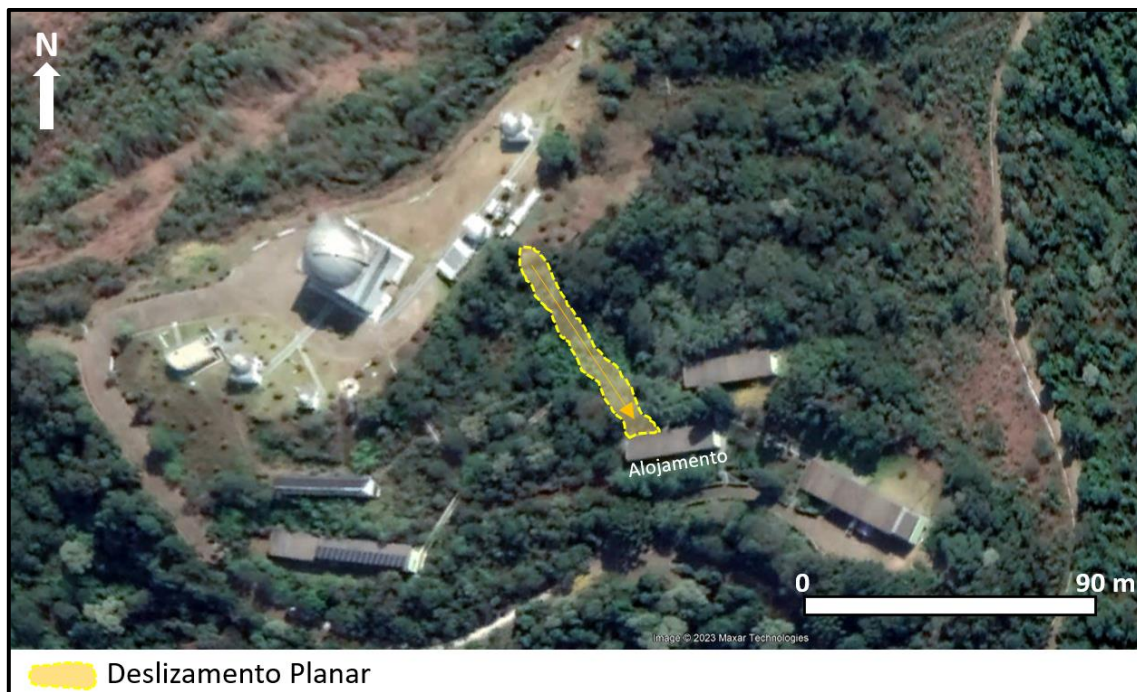
Figura 10 – Imagem do Google Earth que mostra o local do deslizamento planar ocorrido em 28 de dezembro de 2022, o qual danificou parte de um acesso e atingiu um dos alojamentos gerando danos de pequena monta.
