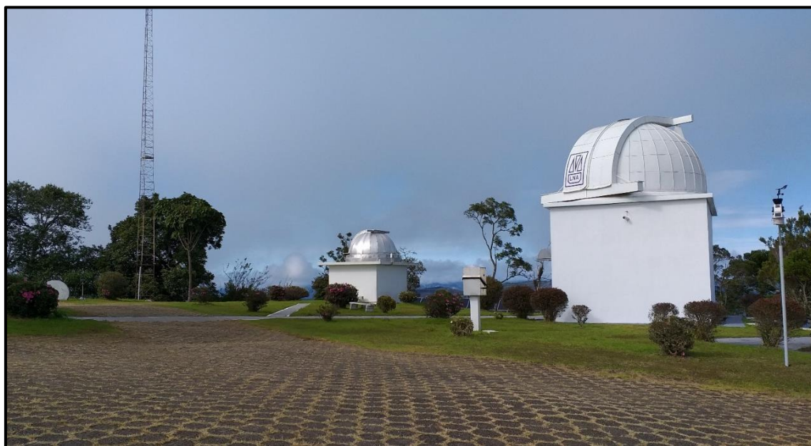
Figura 2 – Foto de parte das instalações do OPD no topo do Pico dos Dias, em terreno aplainado resultante de trabalho de terraplenagem.
