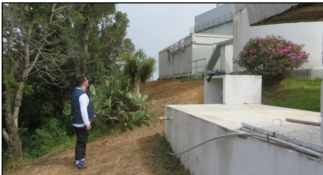
Figura 4 – Área a jusante das instalações hidráulicas e da infraestrutura do telescópio russo, onde podem ser observados aterramentos mais recentes.
