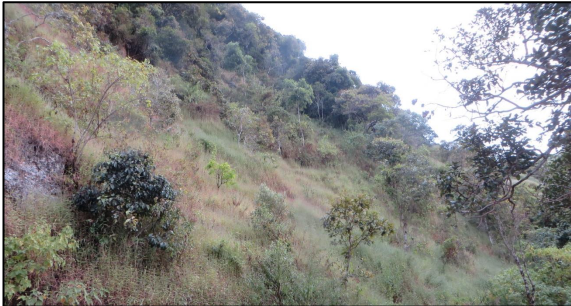
Figura 20 – Foto da encosta do ponto P-2 onde se observam a grande amplitude e alta declividade do talude, constituído por solos rasos sobre rocha. Notar vegetação de médio a grande porte no topo.
