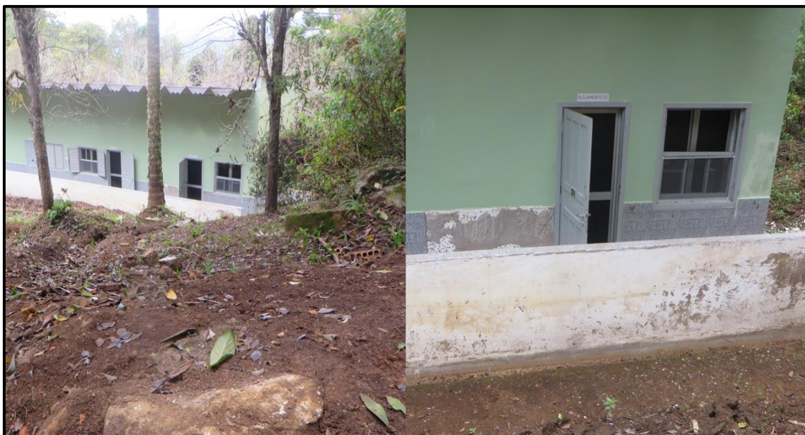
Figura 13 – Imagens do alojamento atingido pelo deslizamento. Na foto da direita observam-se marcas da lama na mureta de proteção e a janela que foi destruída e substituída após o acidente.
