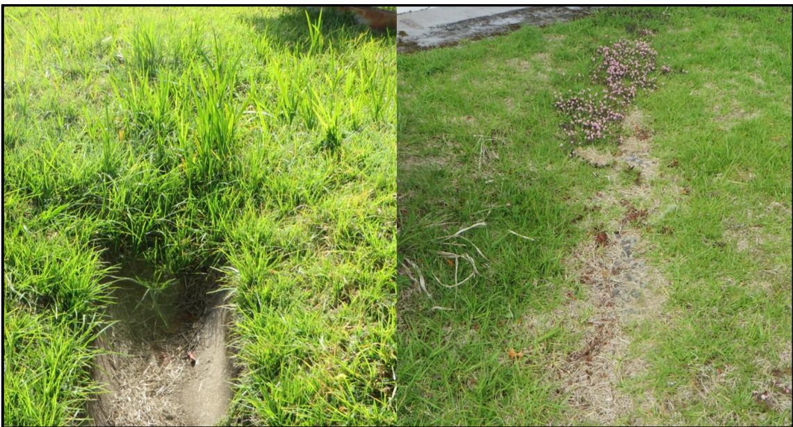
Figura 8 – Fotos da drenagem que mostram, na figura da esquerda, a terminação no próprio gramado e na figura da direita, a canaleta está preenchida com um “colchão drenante”, com britas.
