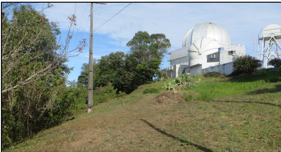
Figura 3 – Foto da borda da área aplainada do topo mostrando várias saias de aterro já consolidadas e protegidas pelo gramado.
