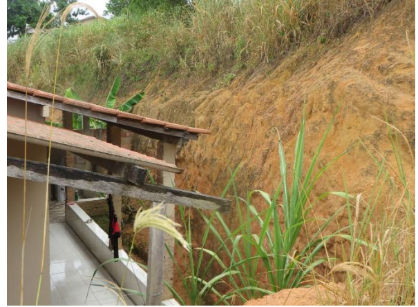
Figura 7: Detalhe da foto anterior mostrando varanda construída sob corte verticalizado com cerca de 3,0 m de amplitude em solo residual maduro. Rua Campo Santo, Bairro Baixo Niterói.
