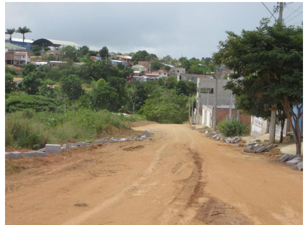
Figura 11: Processo de urbanização da Rua Zelita Ribeiro de Barros. Não foi observado instalação de rede de drenagem pluvial subterrânea.
