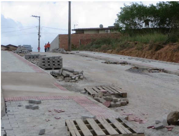
Figura 10: Urbanização com pavimentação da Rua das Laranjeiras. Não foi observado neste trecho implantação de rede de drenagem pluvial subterrânea.
