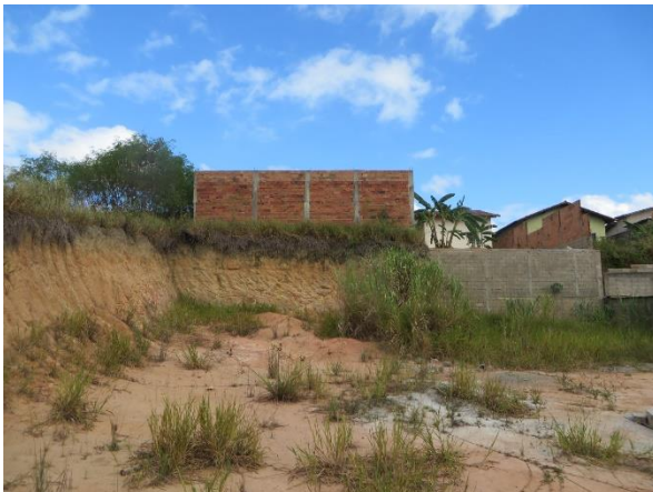
Figura 8: Desaterro, cortes verticais de até 3,0 m de amplitude, muros de contenção e edificações à Av. Parque Itaúnas, Bairro Vista do Balneário.
