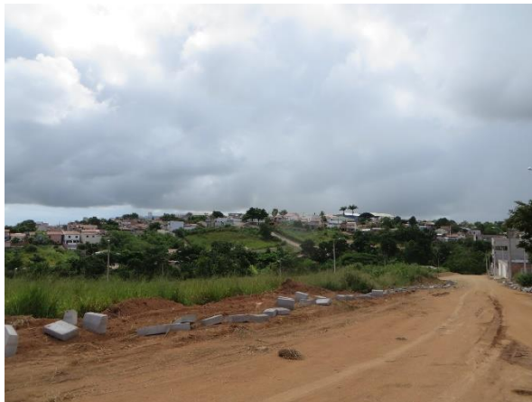
Figura 2: Vista parcial da Sede de Mucurici mostrando o relevo predominantemente colinoso, sem diferenças de nível importantes.
