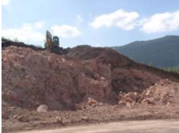
Corte de estrada onde dominam sedimentos eólicos do Botucatu, capeados ao fundo por derrame de basaltos.
