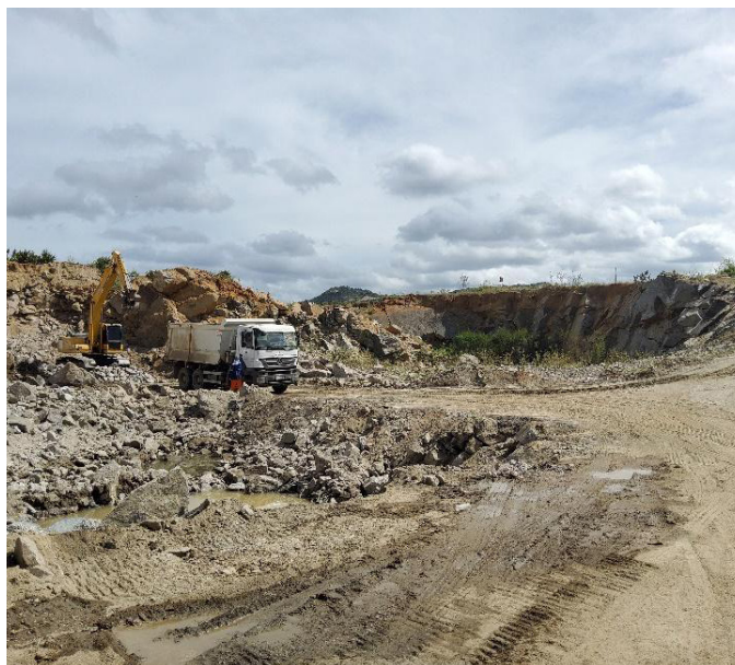
Foto: Pedreira ativa para extração de brita no município de Lagoa Grande.
