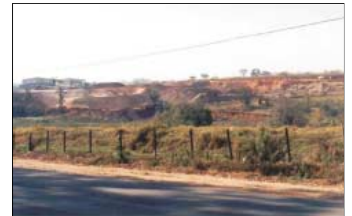
Foto 84 - Fábrica de lajes e tijolos Barrobelo.
