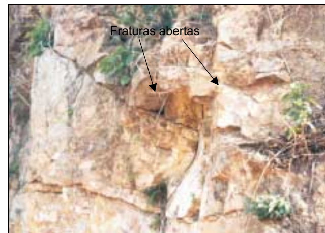
Fotos 102 e 103 - Devido ao tectonismo rúptil distensivo a que foram submetidas as rochas do domínio 10, em muitos lugares encontram-se densamente fraturadas, conseqüentemente, são bastante percolativas e desestabilizam-se com facilidade quando expostas em taludes de corte.
