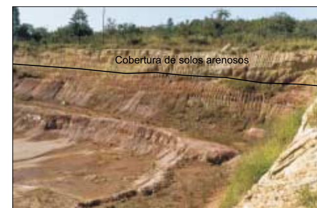
Foto 85 - Cava de mineração de argila próxima a Tambaú. A porção superior do talude é sustentada por solo arenoso de alta permeabilidade e porosidade. A porção abaixo é sustentada por sedimentos argilosos da Formação Corumbataí, quase que impermeáveis.
