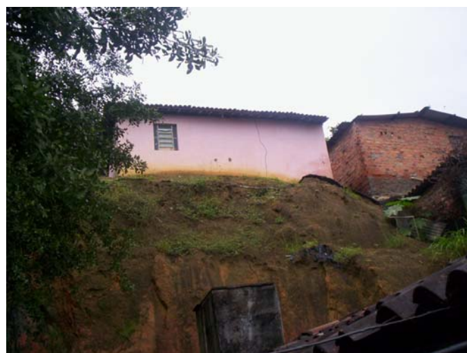
Foto 4.3: a) Vista aérea do deslizamento ocorrido no Córrego do Boleiro em 1996. (foto extraída de Alheiros, 1998). b) Situação típica em áreas de risco, corte vertical de talude com construção da moradia na área plana logo à frente do corte (foto: cedida por Alheiros).
