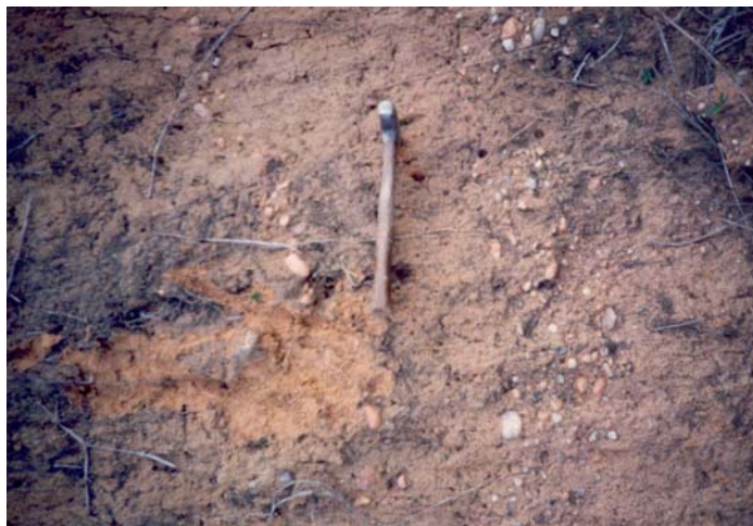
Foto 3.8: Depósito de colúvio no município de Jaboatão dos Guararapes
