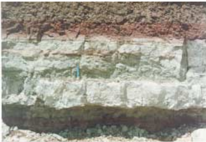
Foto 8 – Detalhe dos bancos de calcilutitos recristalizados com 25cm de espessura, separados por camadas de argilito. Falésia de Alcântara - MA (Foto por T. L. das N. Rodrigues).
